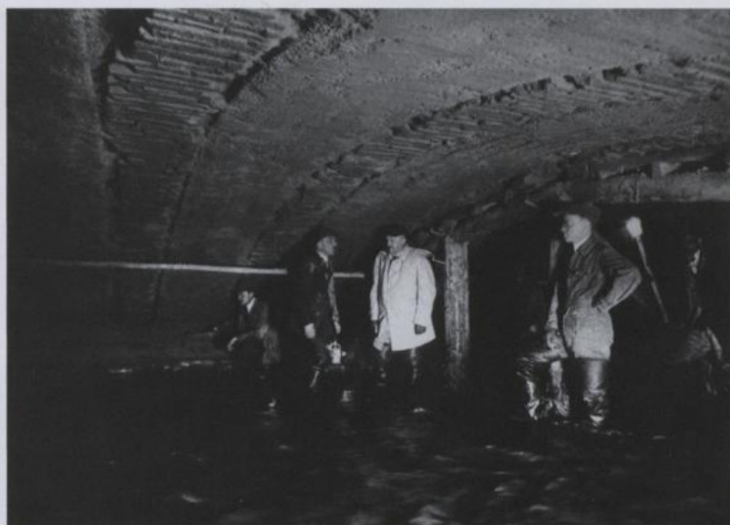
Abb. 63 Vermessungsarbeiten im alten Alserbachprofil, 1947
