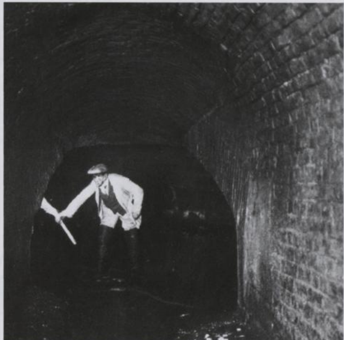
Abb. 38 Die alte Währinger-Bach- Einwölbung von 1848
