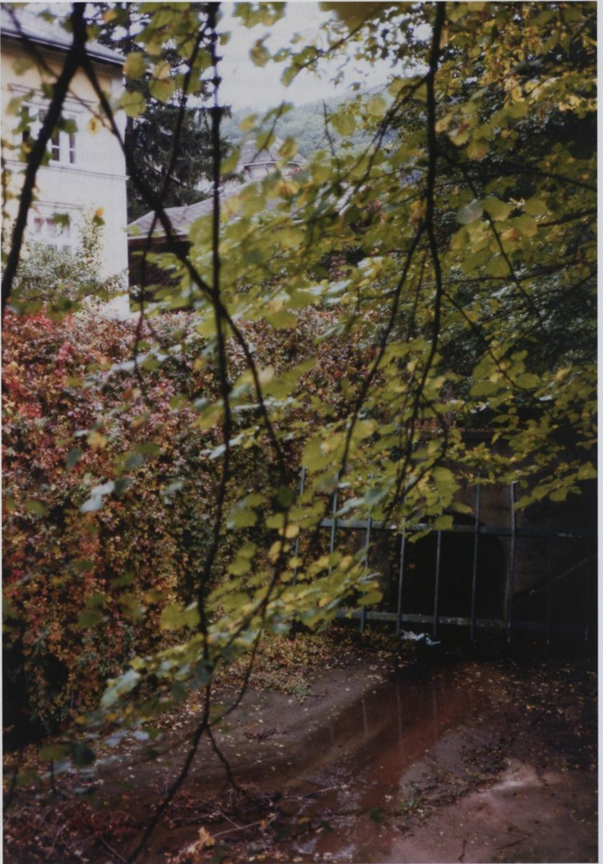
Abb. 51, Das Einlaufwerk des heutigen Bachkanals, errichtet 1899, nächst der Marswiese in Neuwaldegg
