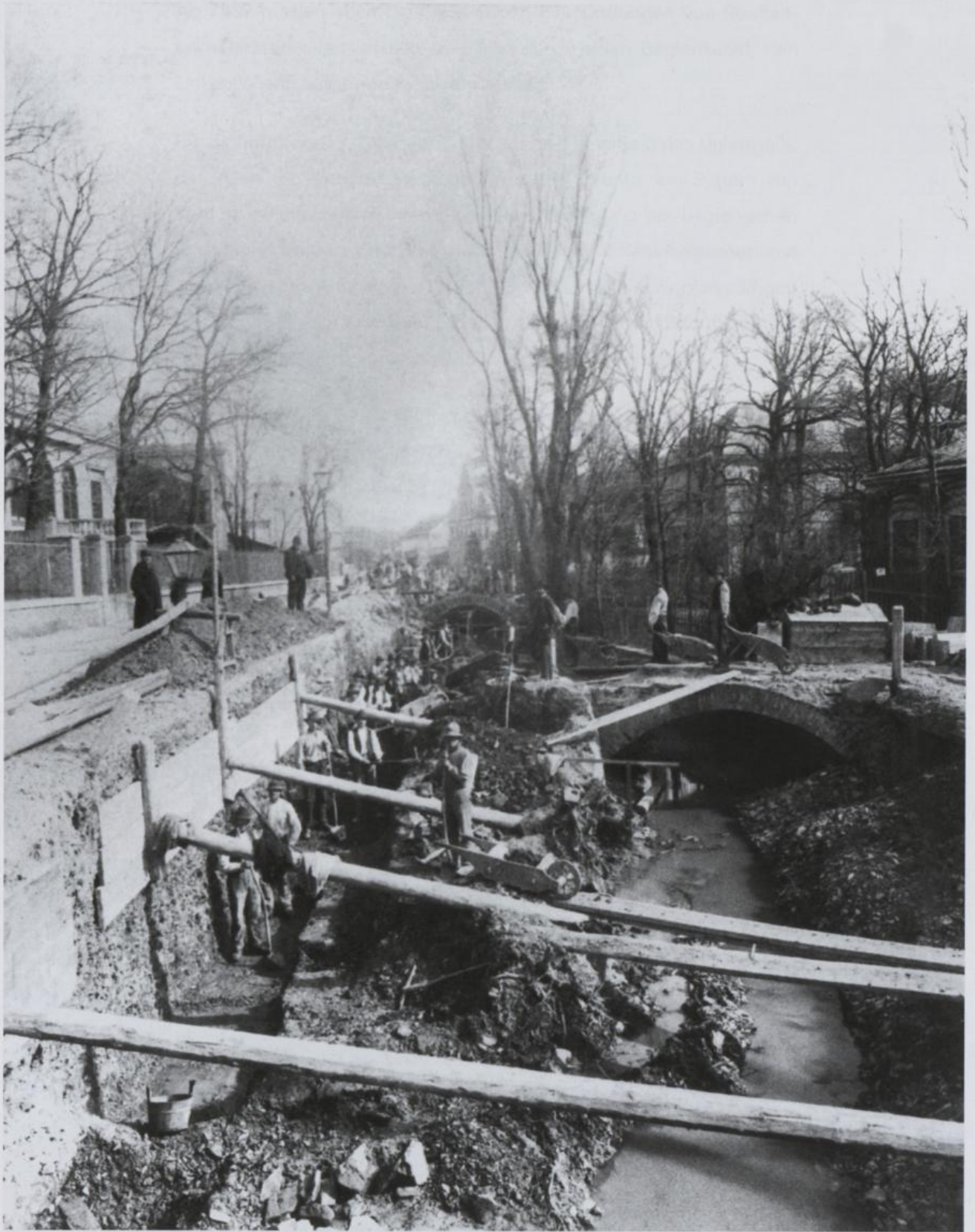
Abb. 39, Die Einwölbungsarbeiten der ehemaligen Gemeinde Neuwaldegg in der Neuwaldegger Straße beginnen 1884
