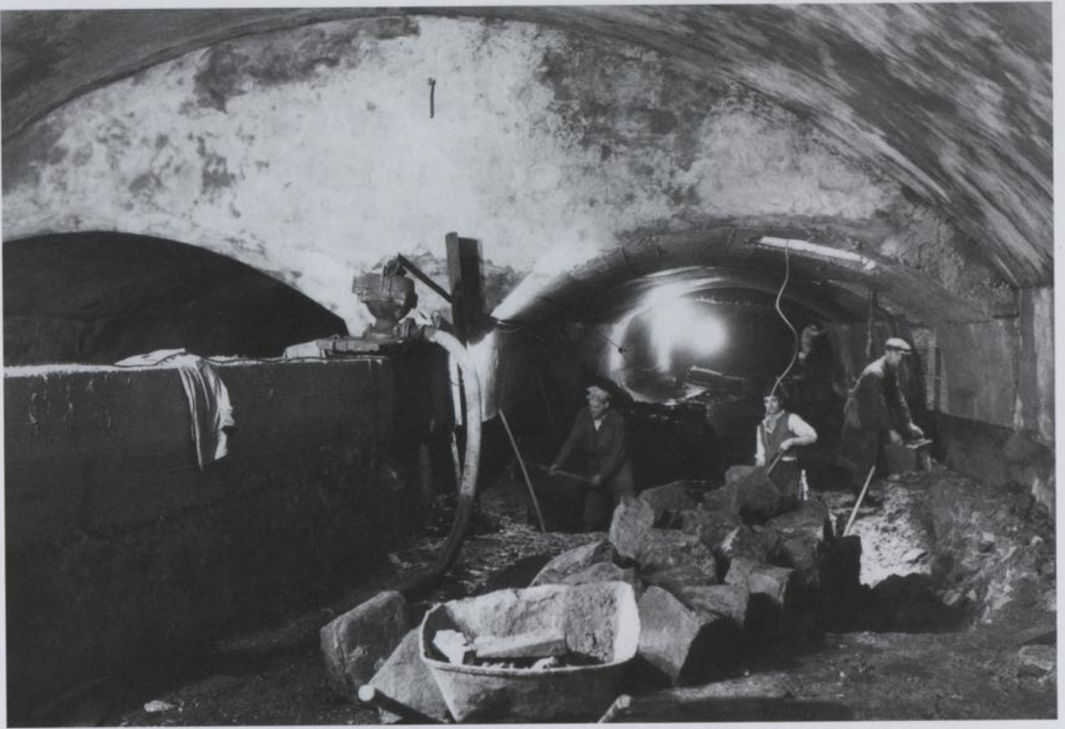
Abb. 61, Die Umbauarbeiten im Vereinigungsbauwerk zum Rechten Hauptsammelkanal um 1950
