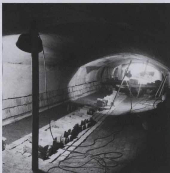
Abb. 64 Die Arbeiten im neuen Doppelprofil um 1950
