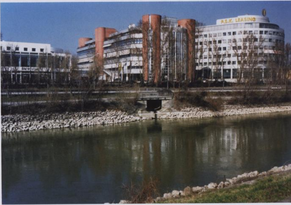
Abb. 99 Der Regenauslass des Krottenbach- kanals an der Heiligenstädter Lände 0Nr. 27b
