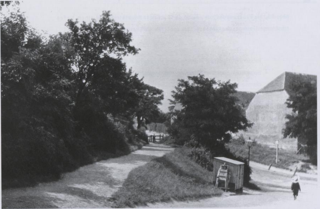
Abb. 94, Der alte und der neue Kreuzungsbereich der heutigen Krottenbachstraße mit der Cottagegasse
