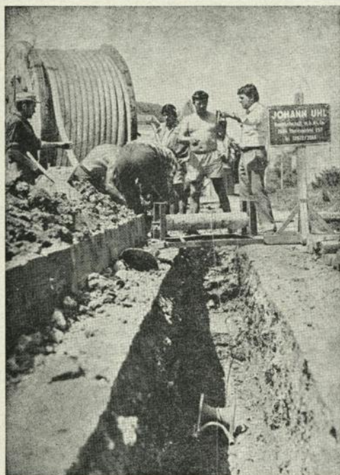
KABELVERLEGUNG FÜR DIE WIENER E-WERKE
