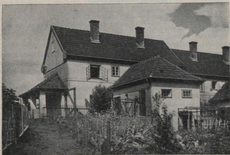
Abb. 33. Gartenseite einer Hausgruppe Siedlung Antäus
