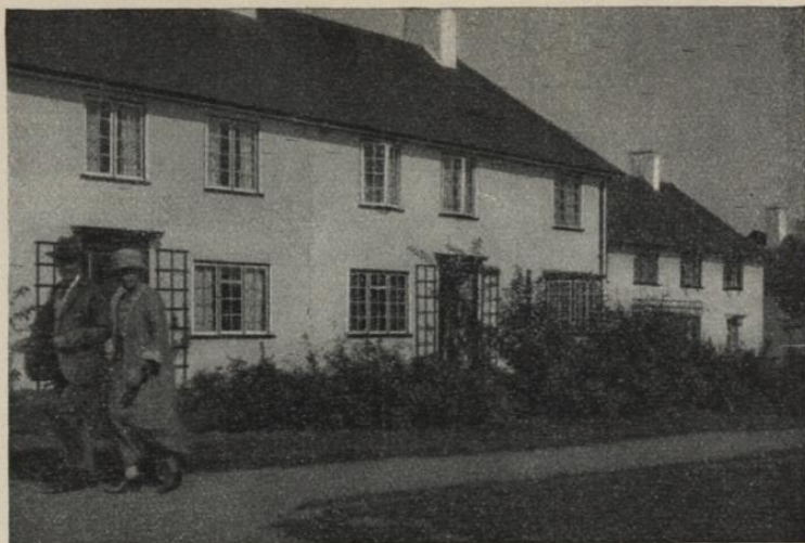
Abb. 5. Arbeiterhäuser in der Gartenstadt Letchworth
