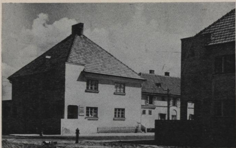
Abb. 66. Siedlung Freihof. Arch. Schartelmüller
