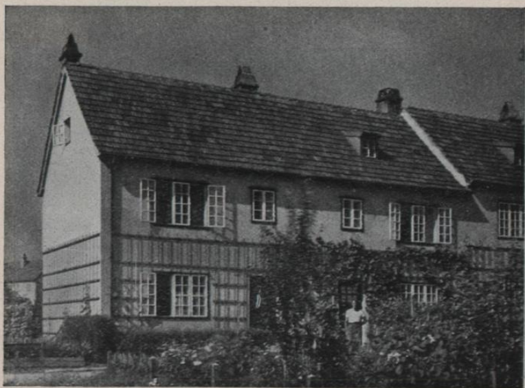
Abb. 90. Siedlung Rosenhügel. Arch. H. Mayer
