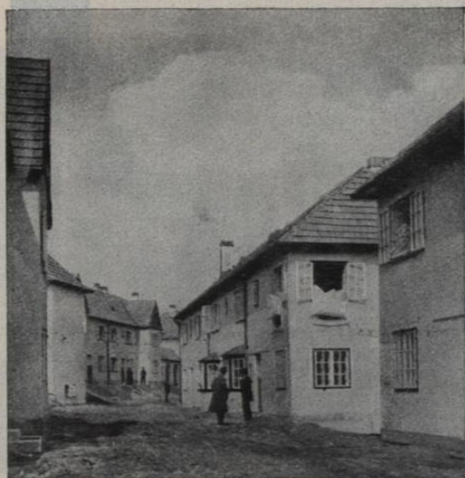
Abb. 94. Siedlung Glanzing. Arch. H. Mayer
