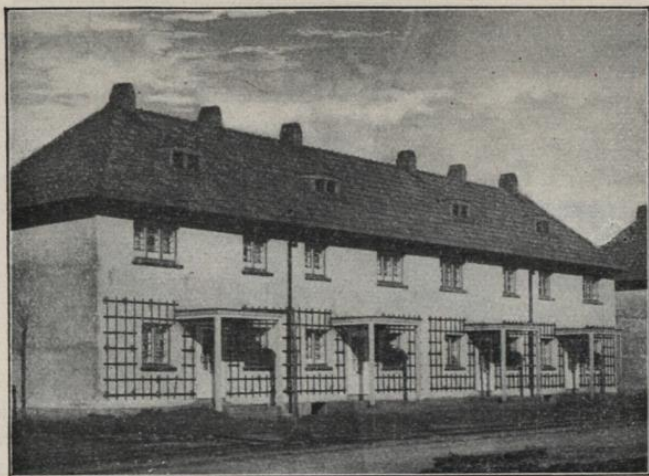
Abb. 11. Hausgruppe der Siedlung Laa am Berg. Arch. Schuster und Schacherl
