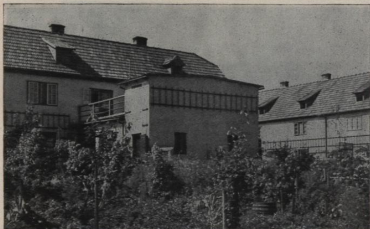
Abb. 93. Siedlung Hoffingergasse. Arch. Dr. Frank
