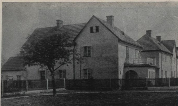
Abb. 69. Siedlung Baumanngasse, 56 Häuser. Arch. Krist
