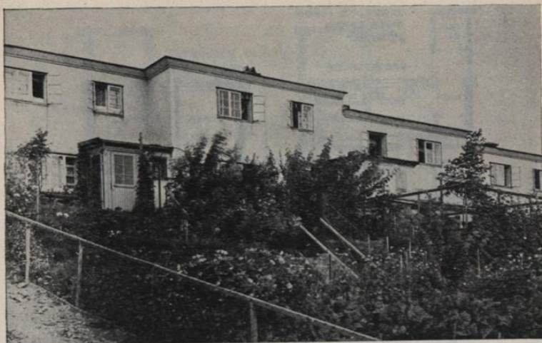
Abb. 27. Siedlung Heuberg, Einfamilienhäuser von der Gartenseite
