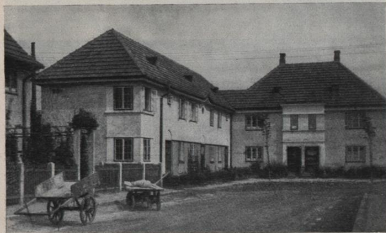
Abb. 63. Siedlung Freihof. Arch. Schartelmüller
