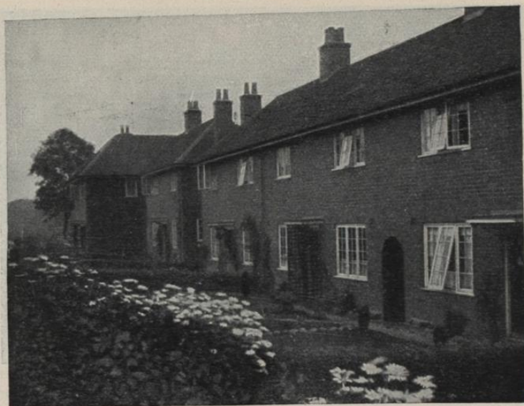
Abb. 6. Welwyn. Kleinhäuser mit Vorgärten
