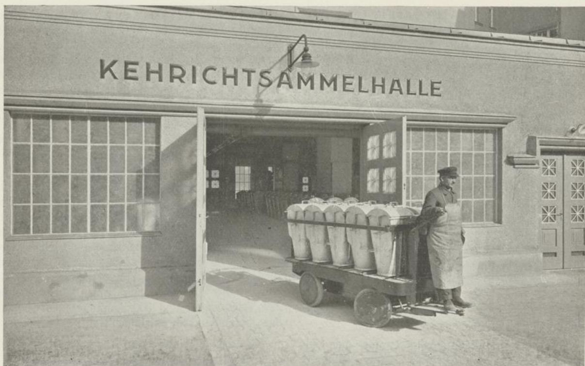
Kehrichtsammelhalle in der Wohnhausanlage Sandeiten. Außenansicht mit Elektrokarren
