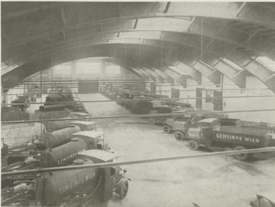
Halle II der Großgarage im V. Bezirk. Ansicht vom Zimmer des Garagemeisters
