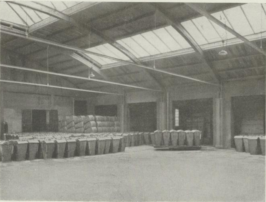
Kübelwäscherei XX, Traisengasse. Übernahme-raum für gereinigte Kehrichttonnen
