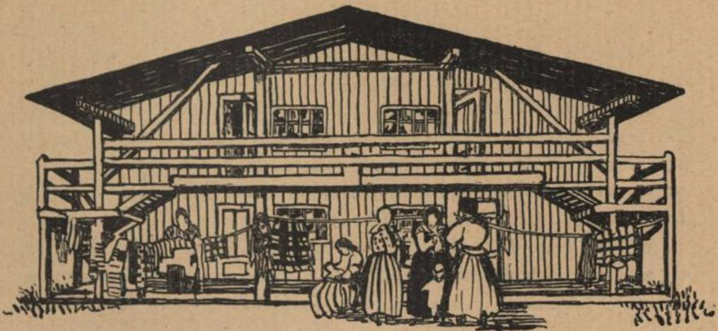
Die Belichtung der Baracke erfolgt durch 2 m hohe, in die obere Etage hineinragende Fenster von 1,20 m Breite; jede Barackenhälfte hat an der Stirnseite unten 4 Türen, oben 2 Türen mit Stiegenabgängen und an beiden Längsseiten unten ebenfalls je 2 Türen ins Freie. Im Innern bestehen ebenfalls zwei Stiegenverbindungen. Die Heizstellen sind mit gemauerten Kaminen und mit Luß'schen Öfen (hohe Eisenblechöfen, innen mit Kugelfsteinen ausge-
