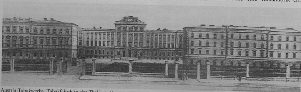
Austria Tabakwerke. Tabakfabrik in der Thaliastraße.
