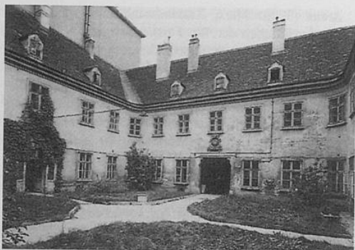
Der Hof des ehemaligen Arenbergpalais vor der Demolierung. Foto, 1957.
