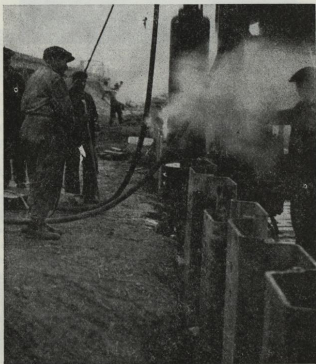
Stahlspundwände schlagen
