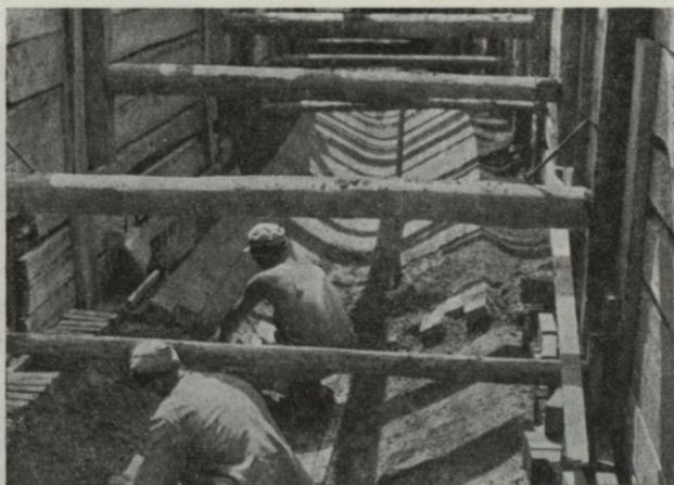
Verlegen von Schlenklinkern
