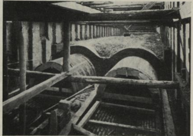
Doppelprofil Entlastungskanal Brünnerstraße
