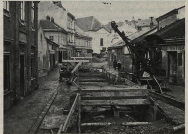
Knotzenbach, Einbau in der Bahnstraße
