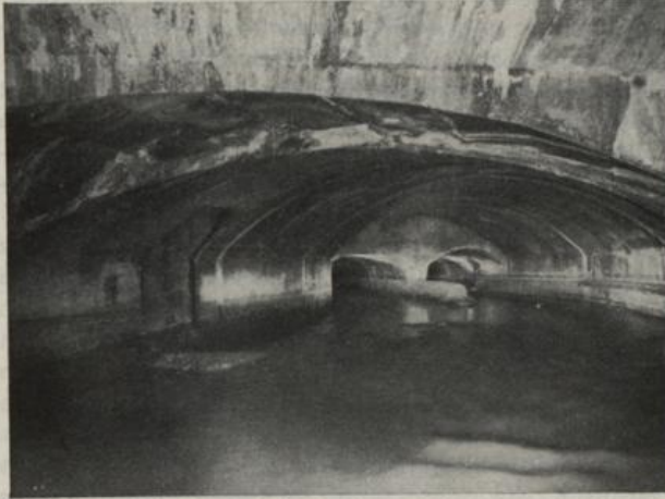
Vereinigungskammer Alsbachkanal
