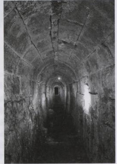
Römischer Abwasserkanal unter der Budengasse in Köln
