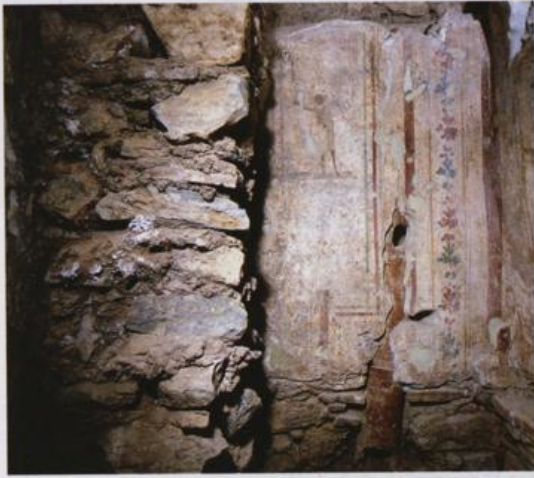
Abb. 8: Eingemauertes Abwasserrohr aus dem Obergeschoss in der Latrine der Wohneinheit 2 des Hanghauses 2
