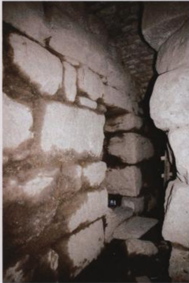
Abb. 26: Sickerkammer unter der Kuretenstraße: Westwand mit Fortsetzung des Hauptabwasserkanals unter der Kuretenstraße und Pfeiler
