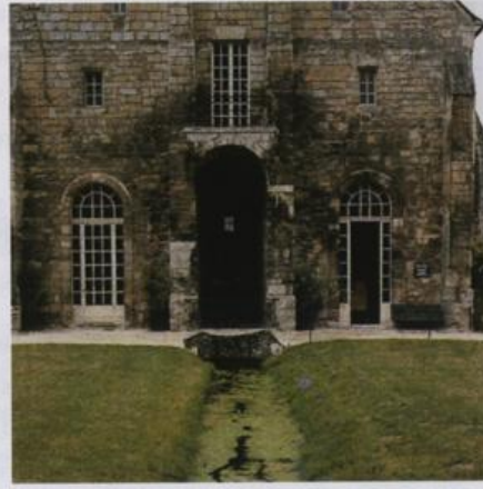
Kloster Royaumont bei Paris, Kanal als Latrinengraben und Wasserradantrieb
