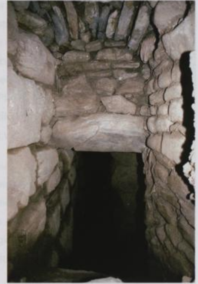
Abb. 24: Abwasserkanal unter Stiegengasse 1 vor der Einmündung in die Sickerkammer im Kreuzungsbereich mit dem Kanal unter der Kuretenstraße. In der Sickerkammer sind der große Pfeiler und die Fortsetzung des Kuretenstraßenkanals zu sehen
