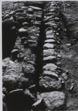
Römische Toiletten- und Abwasserleitung
