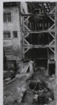
Beispiel einer Fäkaliengrube
