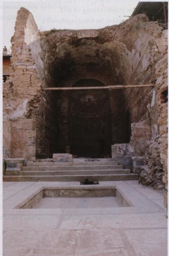
Abb. 20: Basilika der Wohneinheit 6 des Hanghauses 2 mit Bodenbecken im ehemals kreuzgewölbten, marmorverkleideten Vorraum
