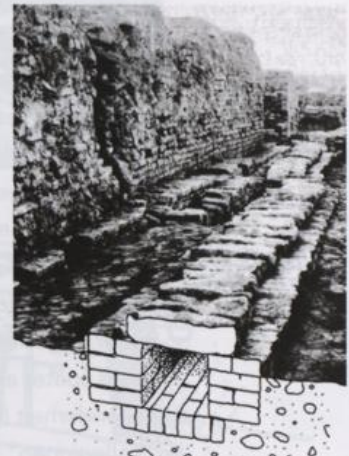
Sammelkanal mit Skizze des Querprofils
