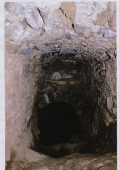
Abb. 21: Abwasserkanal unter Stiegegasse 1 im Kreuzungsbereich mit dem Frischwasserkanal
