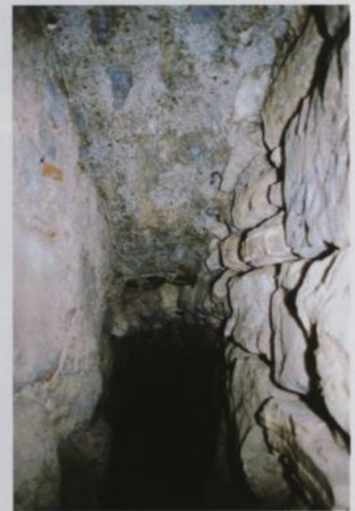
Abb. 15: Kanal unter Stiegegasse 1 mit Abdrücken von Schalbrettern im flachen Gewölbe
