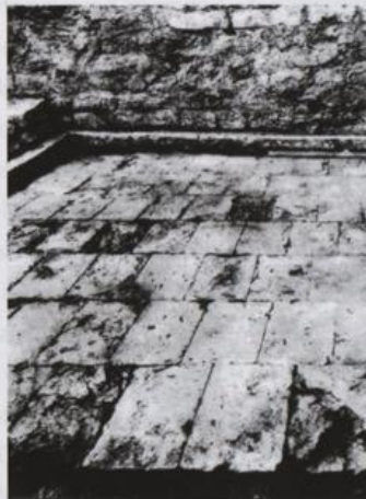
Waschplatz, Mohenjo-Daro, wasserdichter Belag aus Ziegelpflaster
