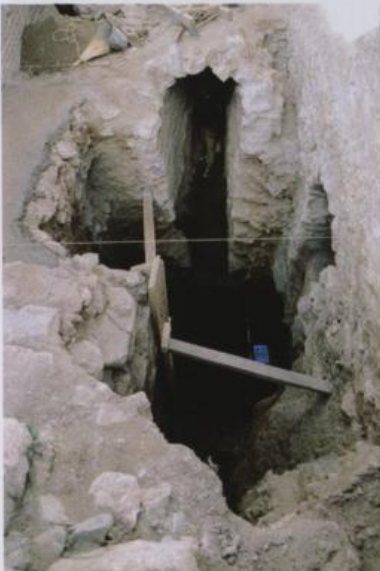
Abb. 22: Fundamentgrube in Stiegegasse 3: Abwasserkanal (Fließrichtung im Bild von unten nach oben) im Kreuzungsbereich mit dem Frischwasserkanal (von rechts nach links)
