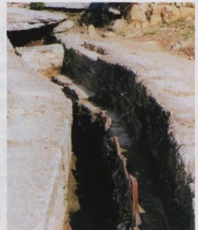
Kanal mit keramischen Platten und Steinabdeckungen, Athen, Agora
