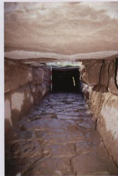
Abb. 32: Abwasserkanal unter der Agora mit flacher Decke
