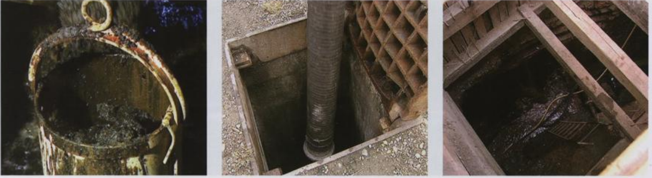
Reinigungsarbeiten in der Wiener Kanalisation
