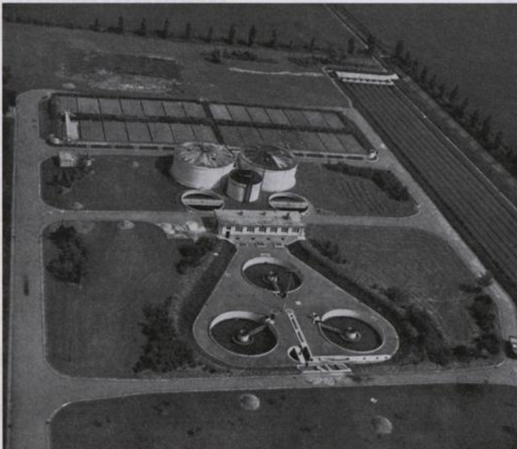
Kläranlage Gelbe Heide
