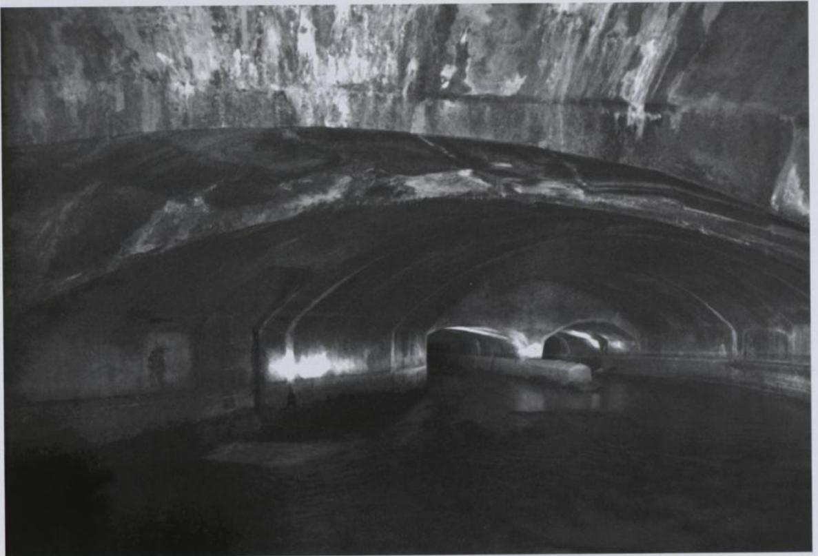
Abb. 62, Das fertig gestellte Vereinigungsbauwerk
