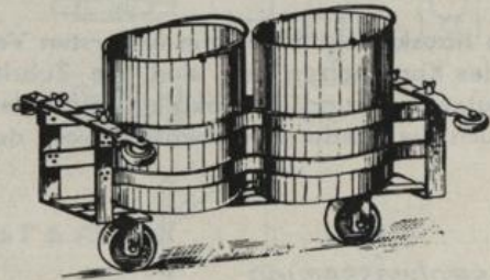
zum Befördern von Schlamm aus schließbaren Kanälen.
