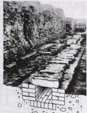
Sammelkanal mit Skizze des Querprofils
