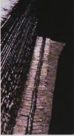
Das Abwasser wurde in genau berechnetem Gefälle durch gemauerte, gedeckte Kanäle nach außerhalb der Stadt geleitet
