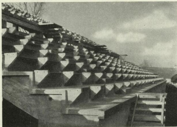
Die neue Betontribüne der Radrennbahn im Wiener Stadion.
