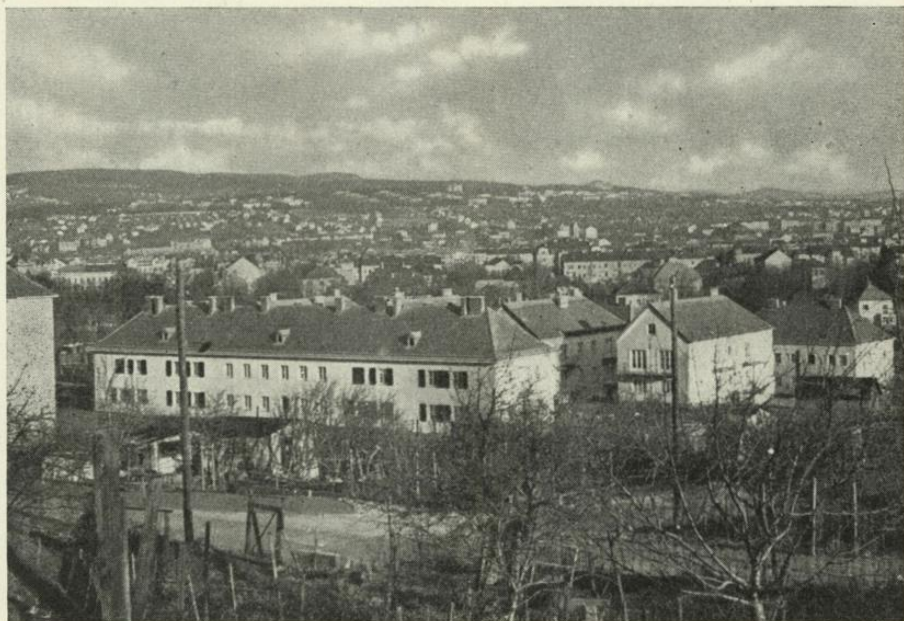
Der Wohnhausblock hat in seiner ganzen Breite eine gute Besonnung der Wohn- und Schlafräume aufzuweisen.
