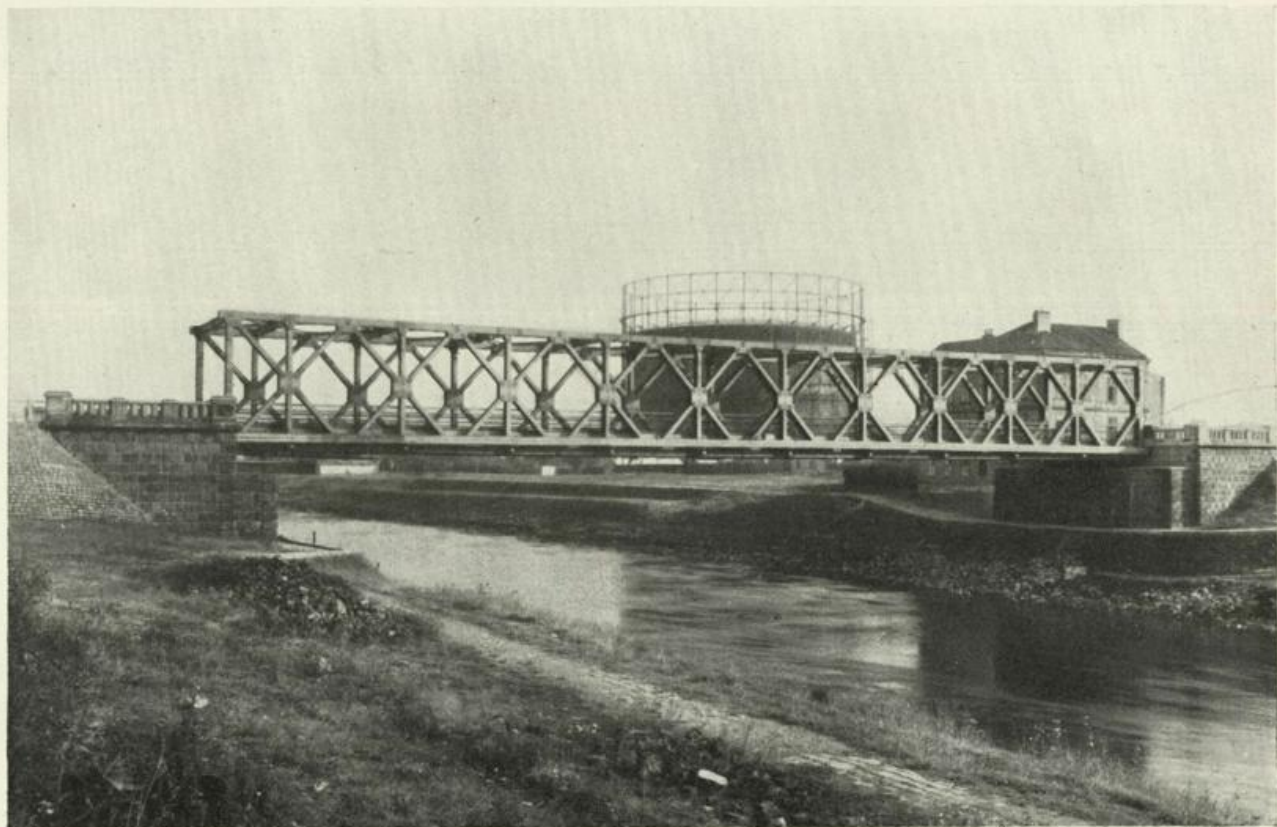
Bedeutend tragfähiger als die alte Heiligenstädter Brücke ist das an ihrer Stelle errichtete Langzeitprovisorium.
