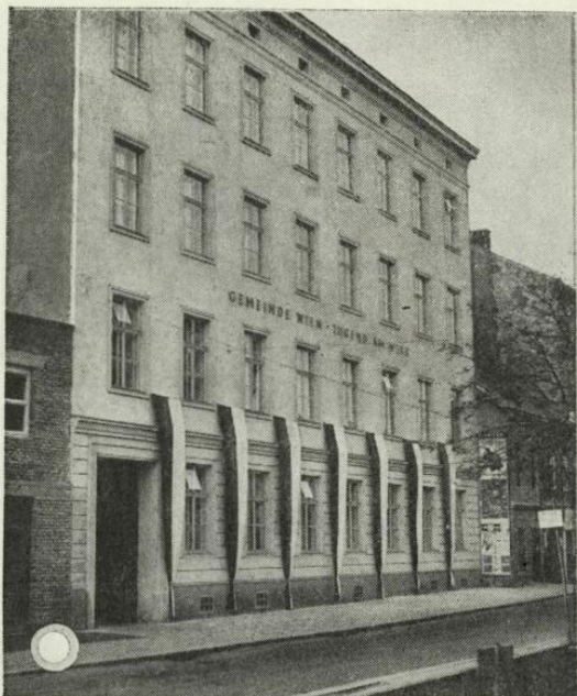
Der Aktion „Jugend am Werk“ wurde ein Zentralgebäude übergeben.
