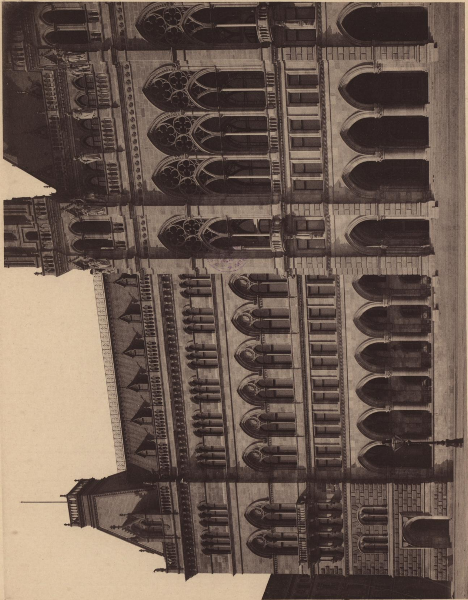
Südöstlicher Flügel der Hauptfacade mit einem Theil der Loggia.
