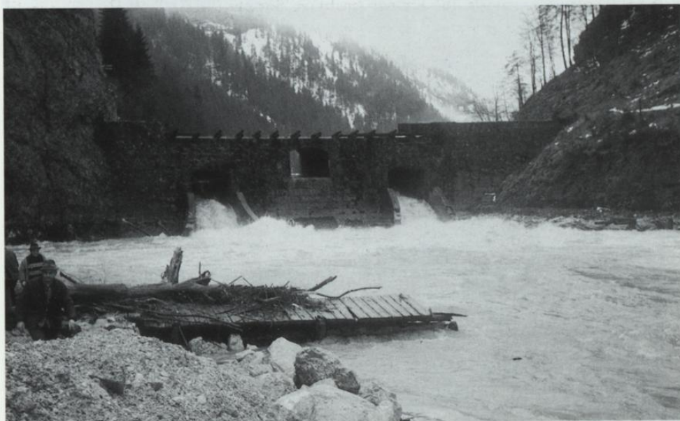
Preszenyklaus: Zerstörung des Vorwehrs durch Hochwasser, 1974
