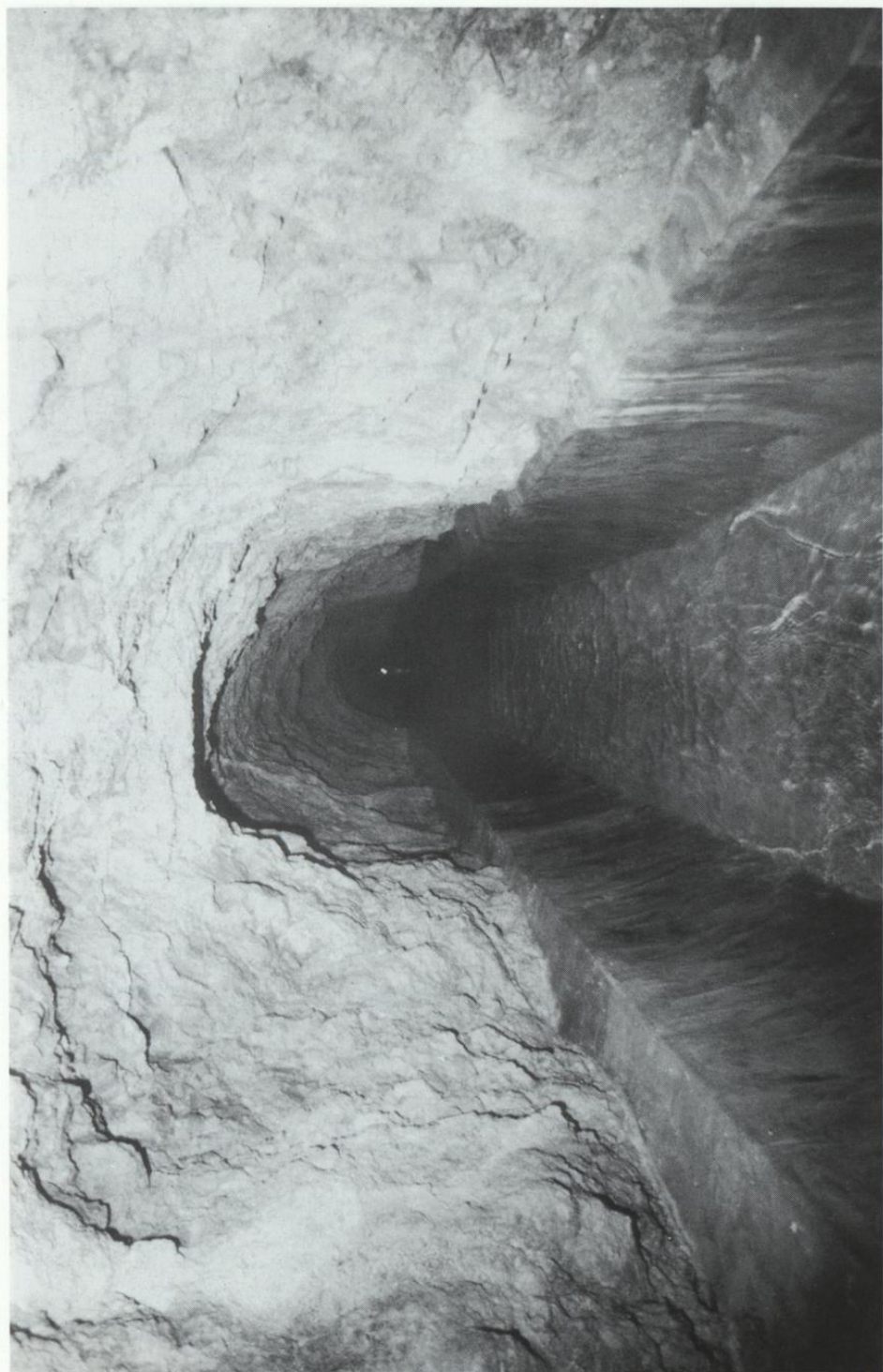
Brunnen im Ableitungsstollen
