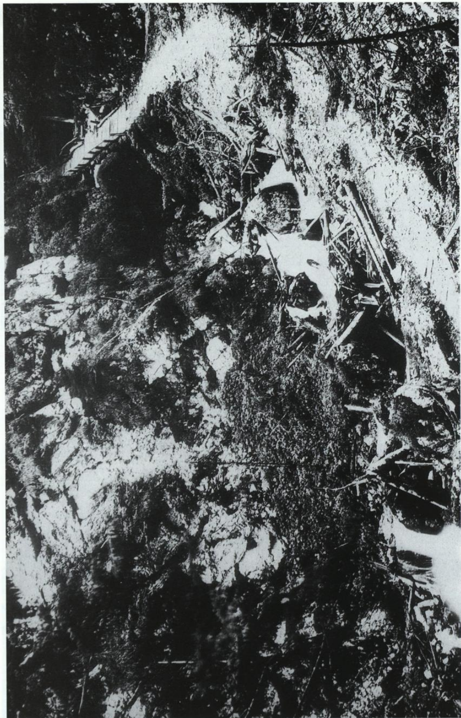
Vom Unwetter 1965 zerstörter Steig
