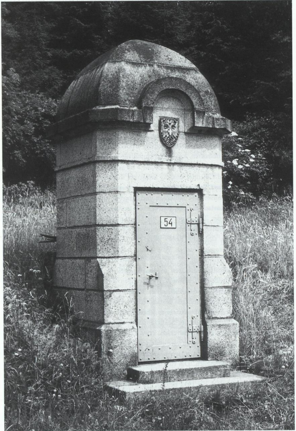
Einstiegsturm 54 beim „Österreicherstollen“, Neustift/Scheibbs
