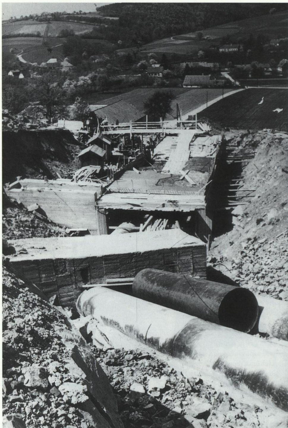
Verlegung der Dükerrohre bei der Autobahnbaustelle Laabenbachdüker
