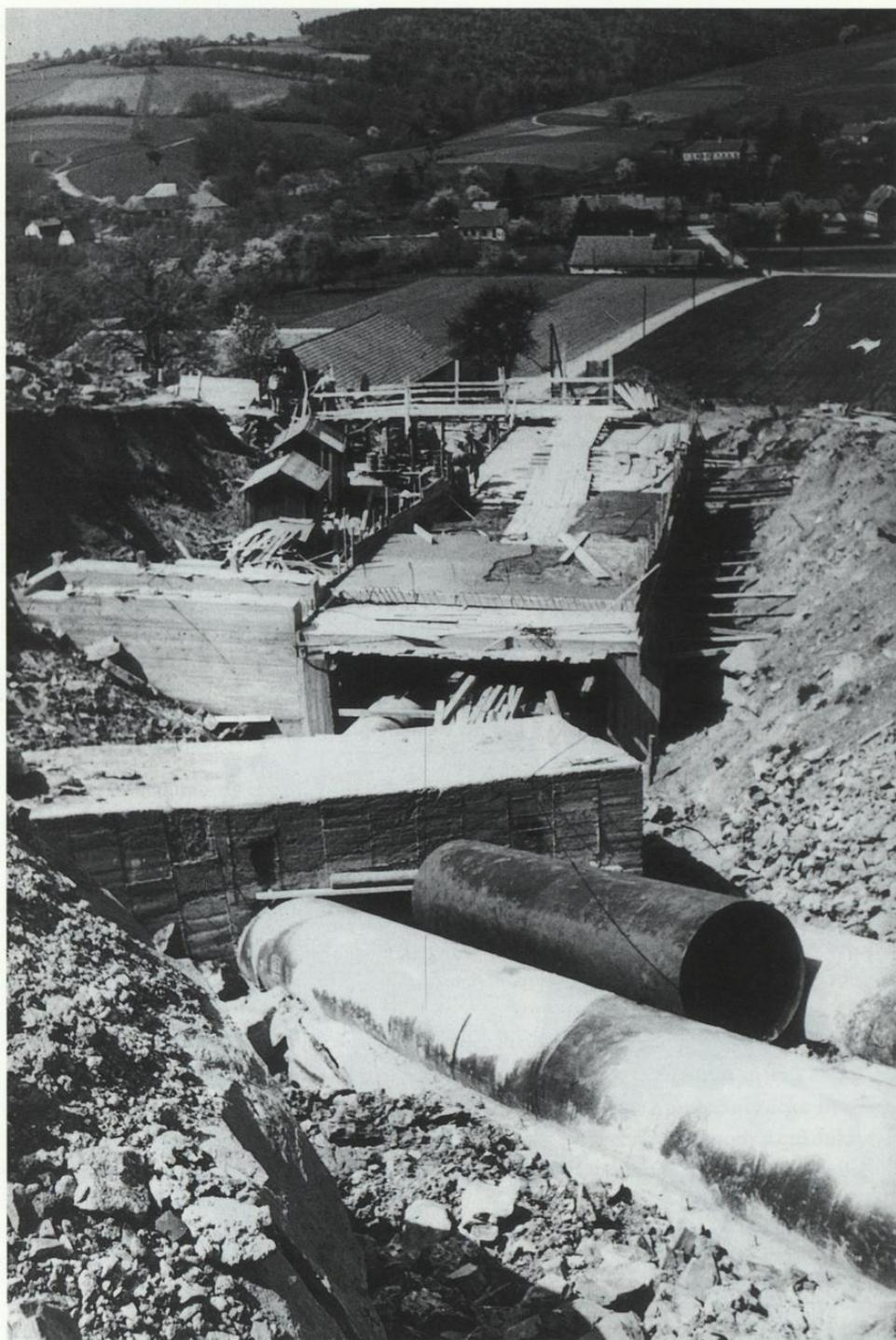
Verlegung der Dükerrohre bei der Autobahnbaustelle Laabenbachdüker
