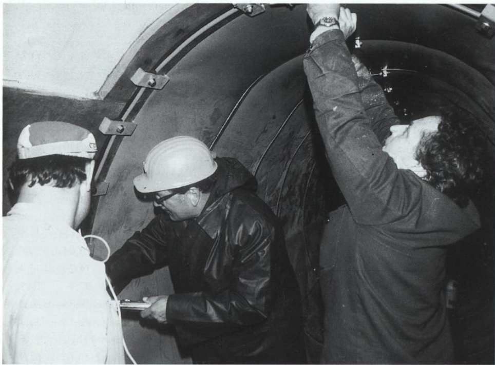
Scheibbs – provisorische Sicherung mit Kunststoffolie
