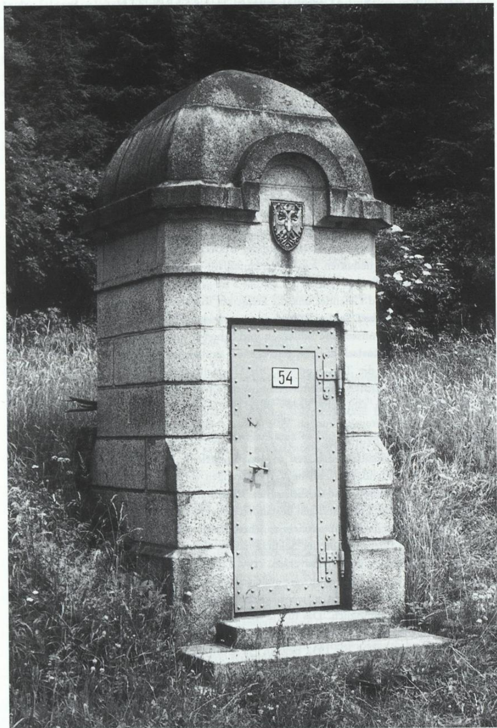
Einstiegsturm 54 beim „Österreicherstollen“, Neustift/Scheibbs
