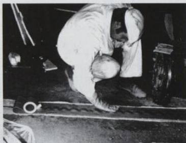
COMBIFLEX – die rasche sichere Abdichtung für Fugen und Risse im Wasserbau (Trinkwasserzulassung)
