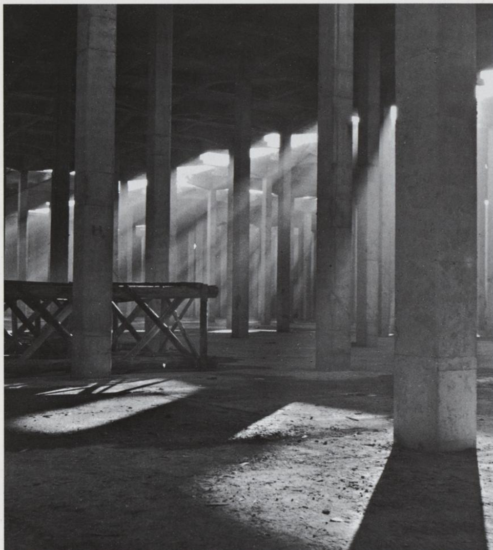
Abb. 47: Im Rohbau fertiggestellte Kammer
