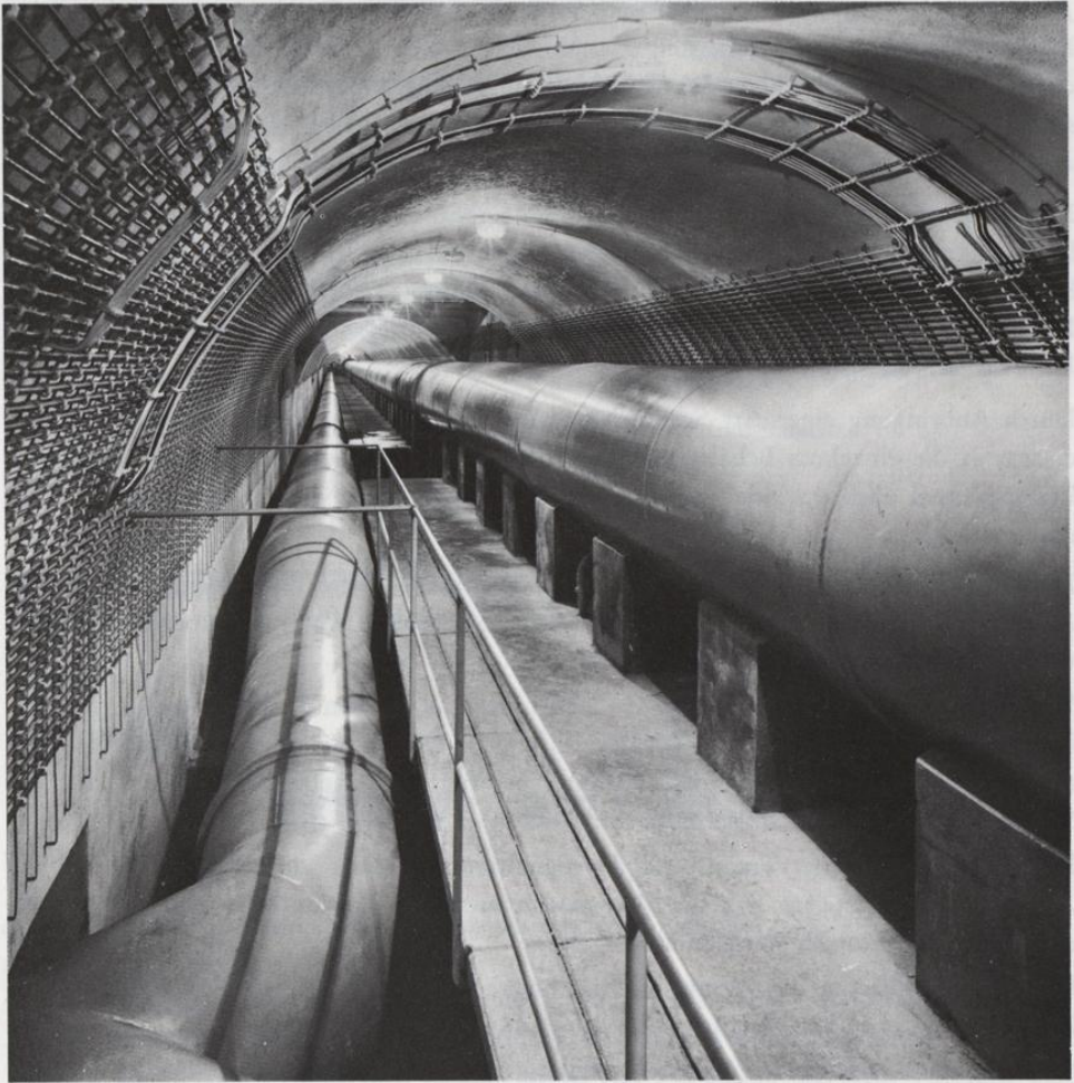
Abb. 46: Neusiedl am Steinfeld, Rohrtunnel
