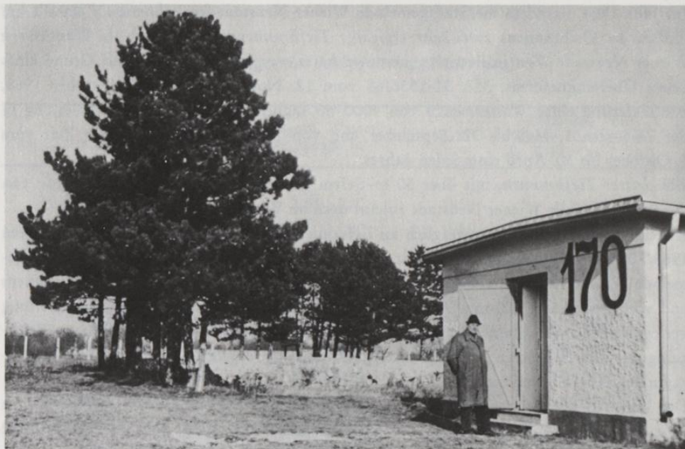
Abb. 53: Schöpfwerk Wöllersdorf, Brunnen 2
