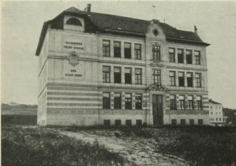
Allgemeine Volks- und Bürgerschule der Stadt Wien in Bögelsdorf, Scheibnergasse, von der Firma mit Niederdruckdampfheizung und elektrisch betriebener Ventilationsanlage eingerichtet.
