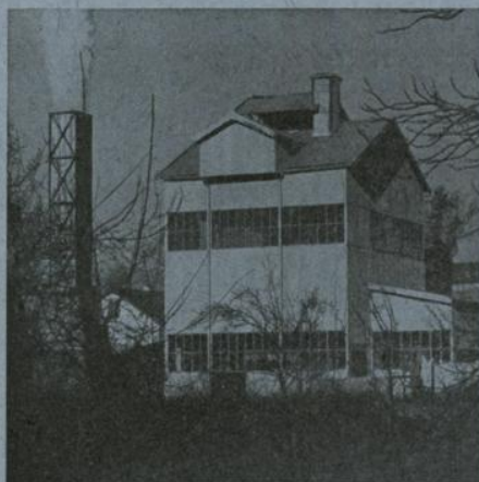
Kompl. Vertikalkammerofen-Anlage „System Didier“ erbaut 1954/55 für das Gaswerk Gmunden
