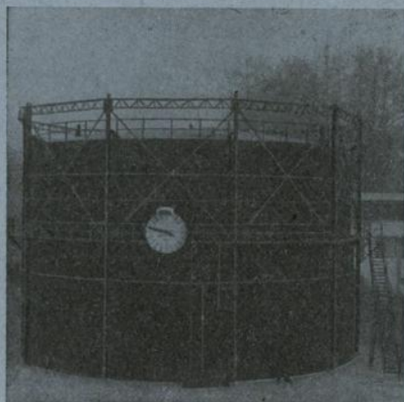
Gasbehälter, 2000 m 3 vollkommen elektrisch geschweißt, erbaut im Jahre 1953 für das Gaswerk Gmunden
