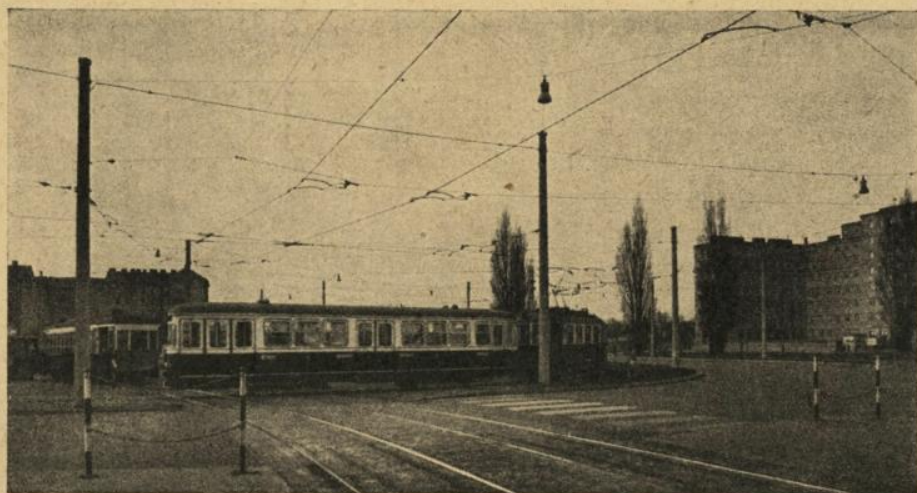
Fahrleitungsanlage nach System Kummeler & Matter, ausgeführt für die Wiener Stadtwerke-Verkehrsbetriebe
