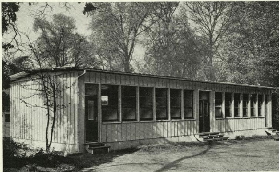
SCHULGEBÄUDE MIT 2 KLASSEN IN STAHLBLECHKONSTRUKTION MONTAGEDAUER: 3—4 WOCHEN
