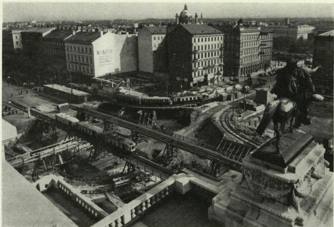
Die Baustelle bei der Opernkreuzung
