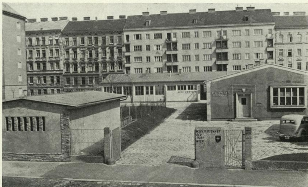
Werkstättenhof der Stadt Wien, Wien 3, Barthgasse
