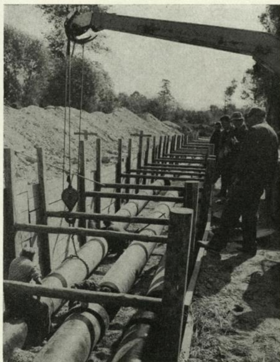
Rohrverlegung für das Grundwasserwerk Lobau
