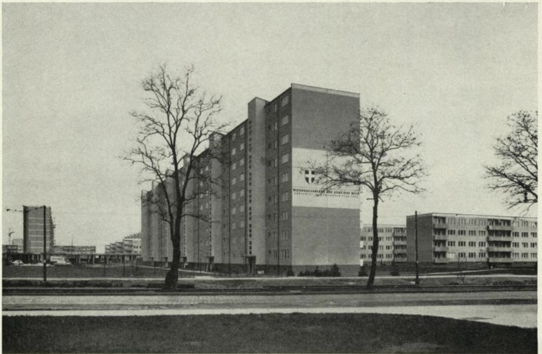
Errichtung einer industriell vorgefertigten Wohnhausanlage in Montagebauweise in Wien 22, Erzhzog Karl-Strasse—Siebenbürger-Strasse
