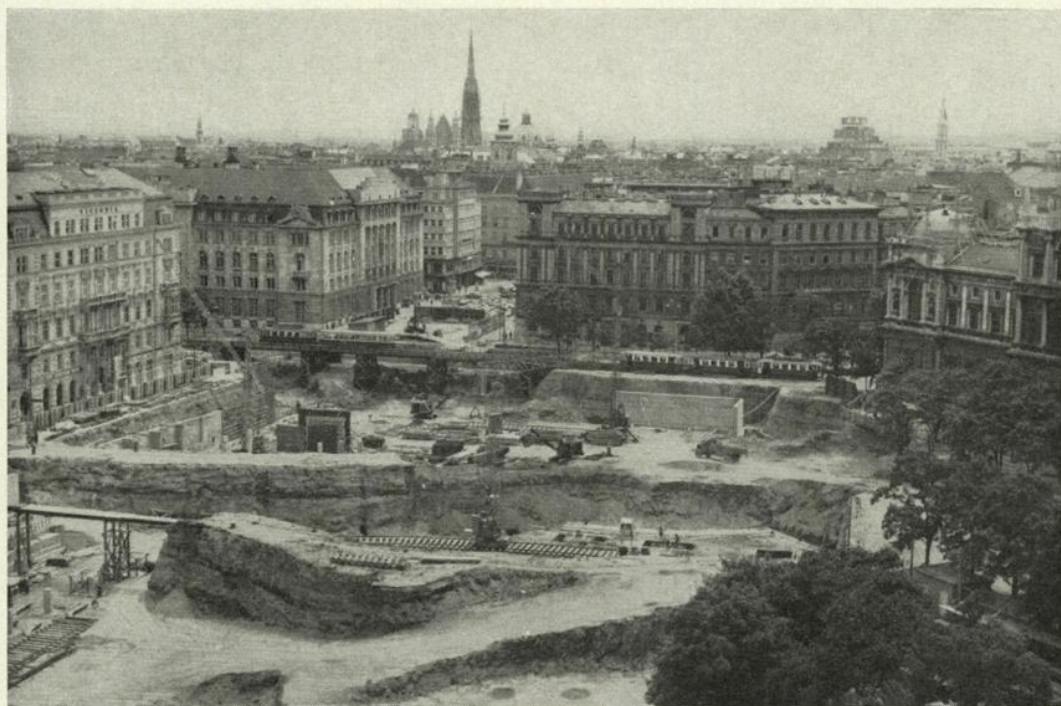
Baustelle am Schottentor
