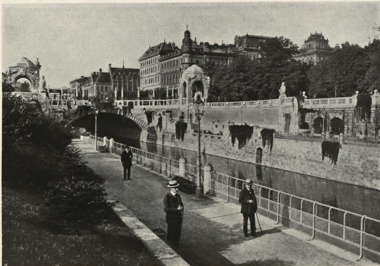
Wienflussterrassen im Stadtpark.
