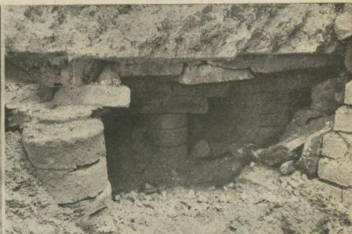
Links: Die im August entdeckten Fundamente des römischen Lagereckturmes im Hause Naglergasse 26 — Rechts: Blick in die im September aufgedeckte römische Warmluftheizungsanlage auf dem Hohen Markt. Oberhalb der Ziegelsäulen am Bildrand der aus Mörtel und Ziegelsplittern bestehende Fußboden
