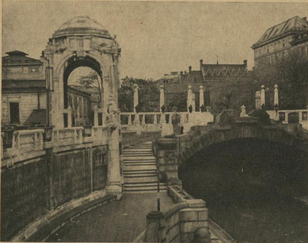
Stiegenanlage beim Stadtpark
