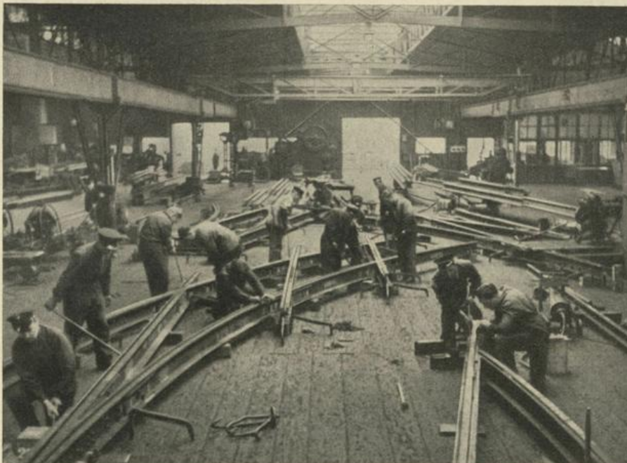
Zusammenfügung einer Weiche mit anschließender Gleiskreuzung
