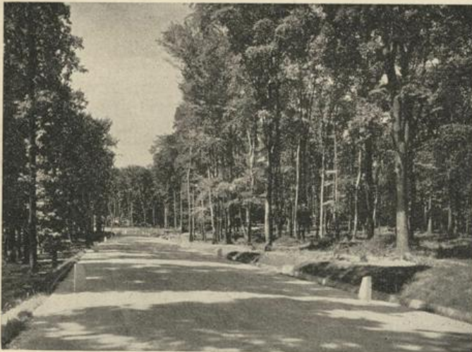
Waldstraße von der Sieveringer Brücke zum Dreimarkstein
