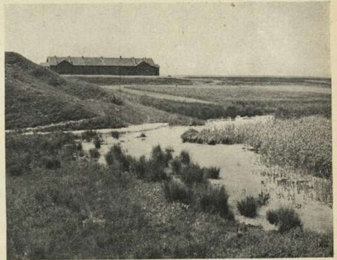
Abstecken steiler Abhänge am Laaerberg
