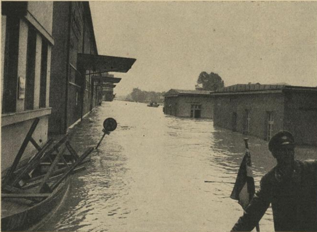
Hochwasser am Handelskai
