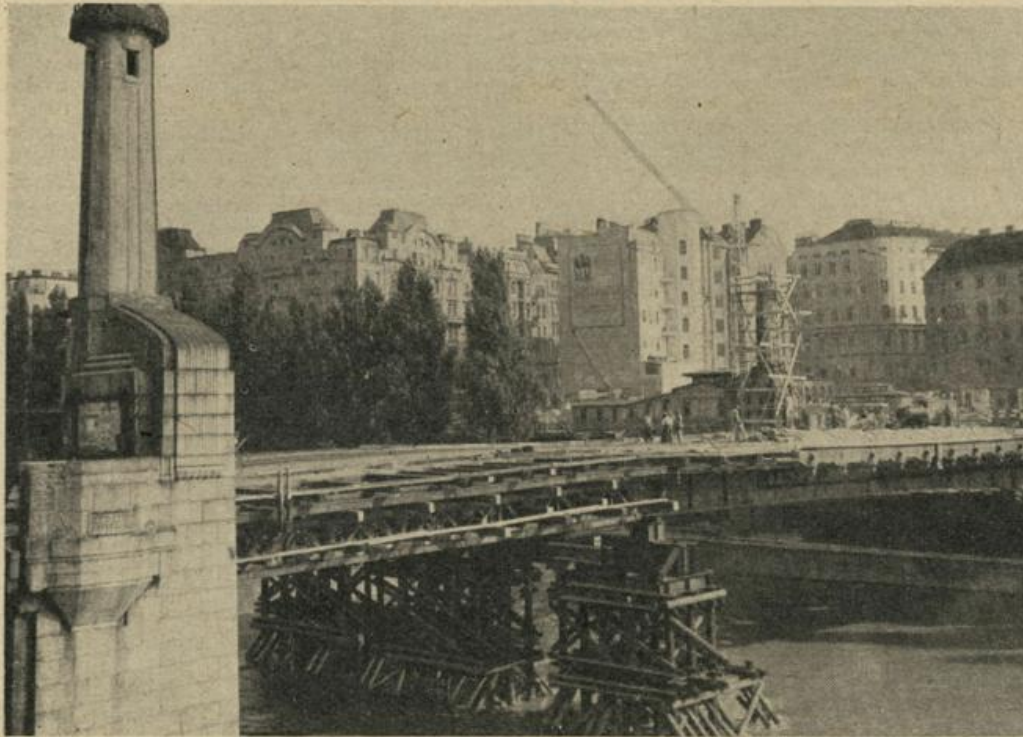
Die alte Schwedenbrücke wird abgebrochen
