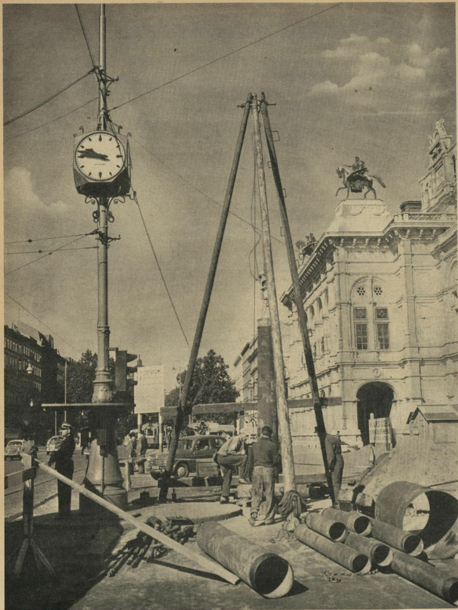
Vorarbeiten für den Fußgängertunnel unter der Opernkreuzung
