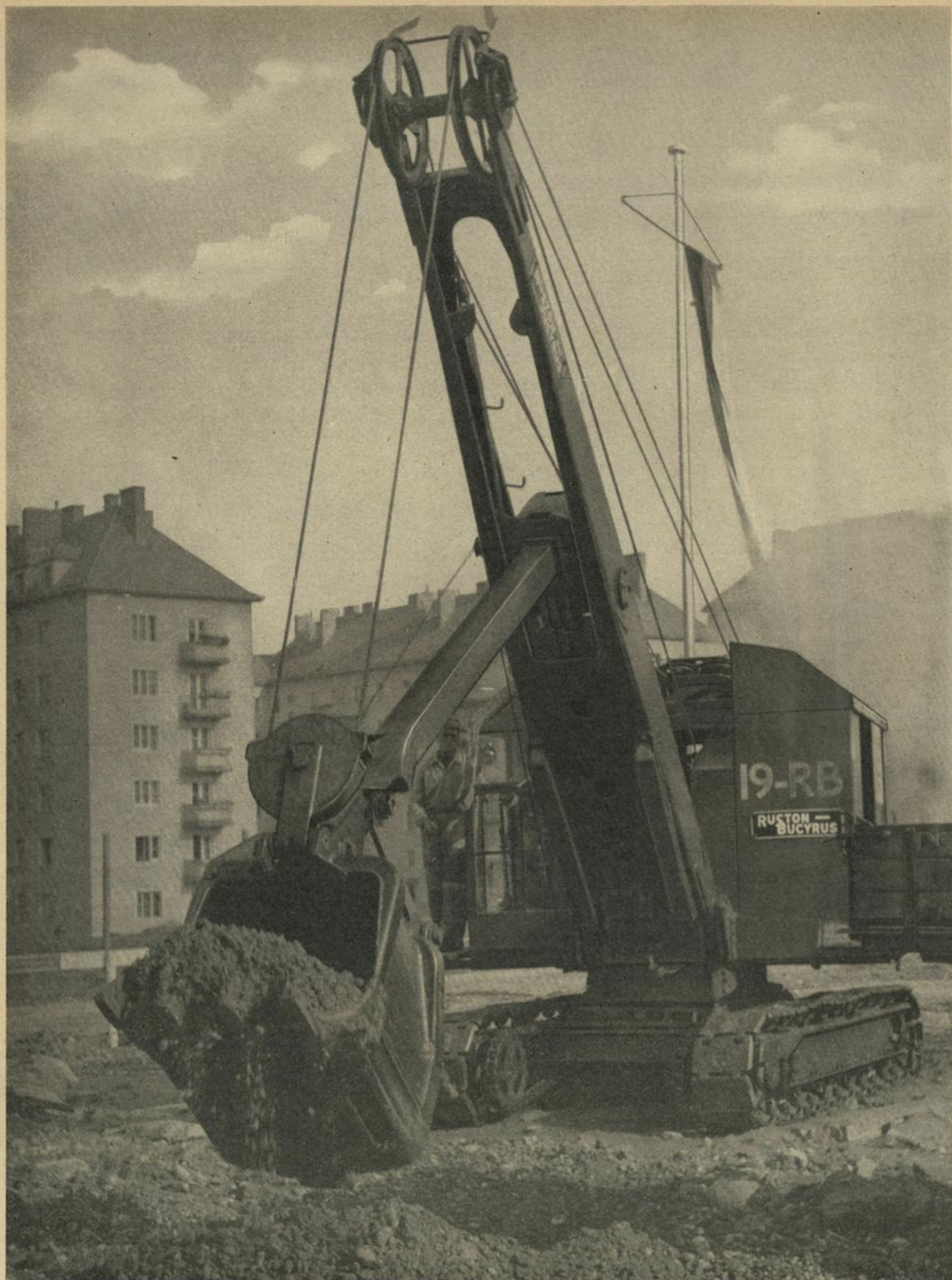
Die erste Baggerschaufel zum Bau des Wohnhochhauses beim Matzleinsdorfer Platz
