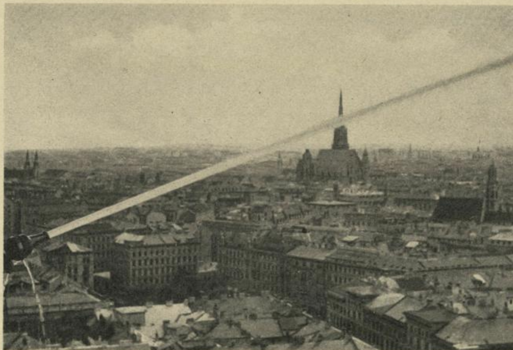
„Feuerprobe“ auf dem Dach des Schottenring-Hochhauses
