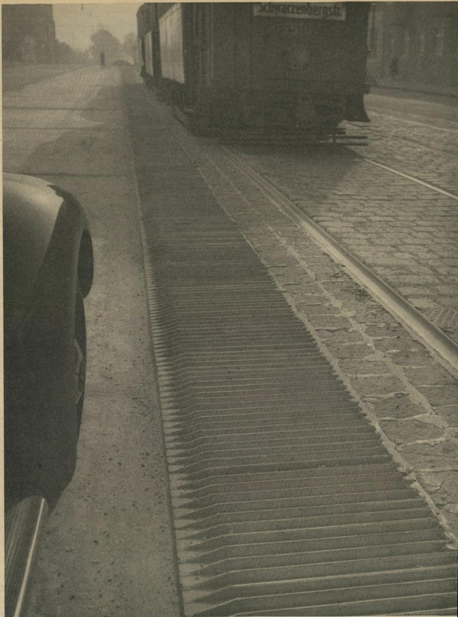
Neuartige Abgrenzung zwischen Fahrbahn und Straßenbahn
