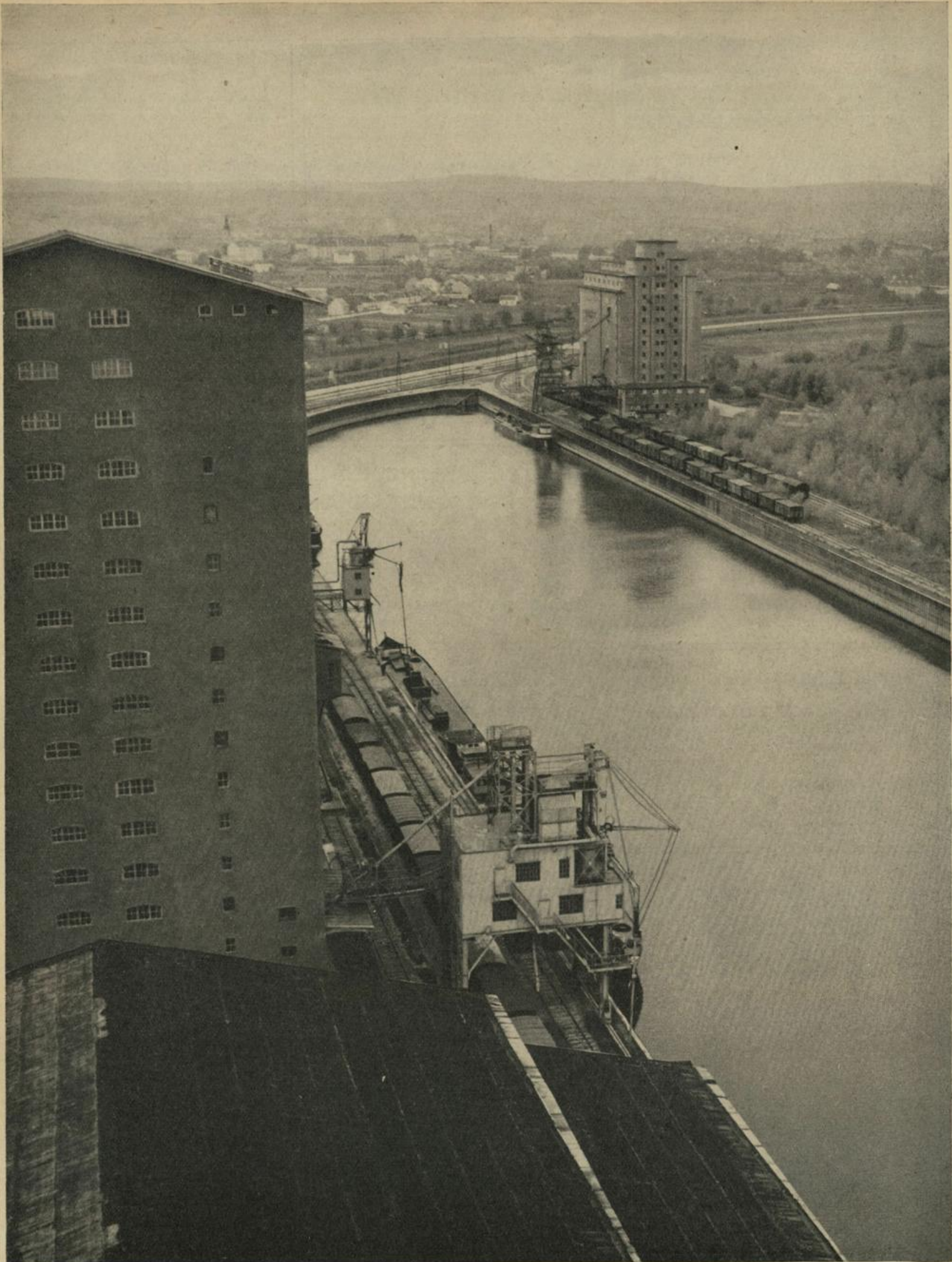
Blick von einem Speicher auf den Hafen Albern
