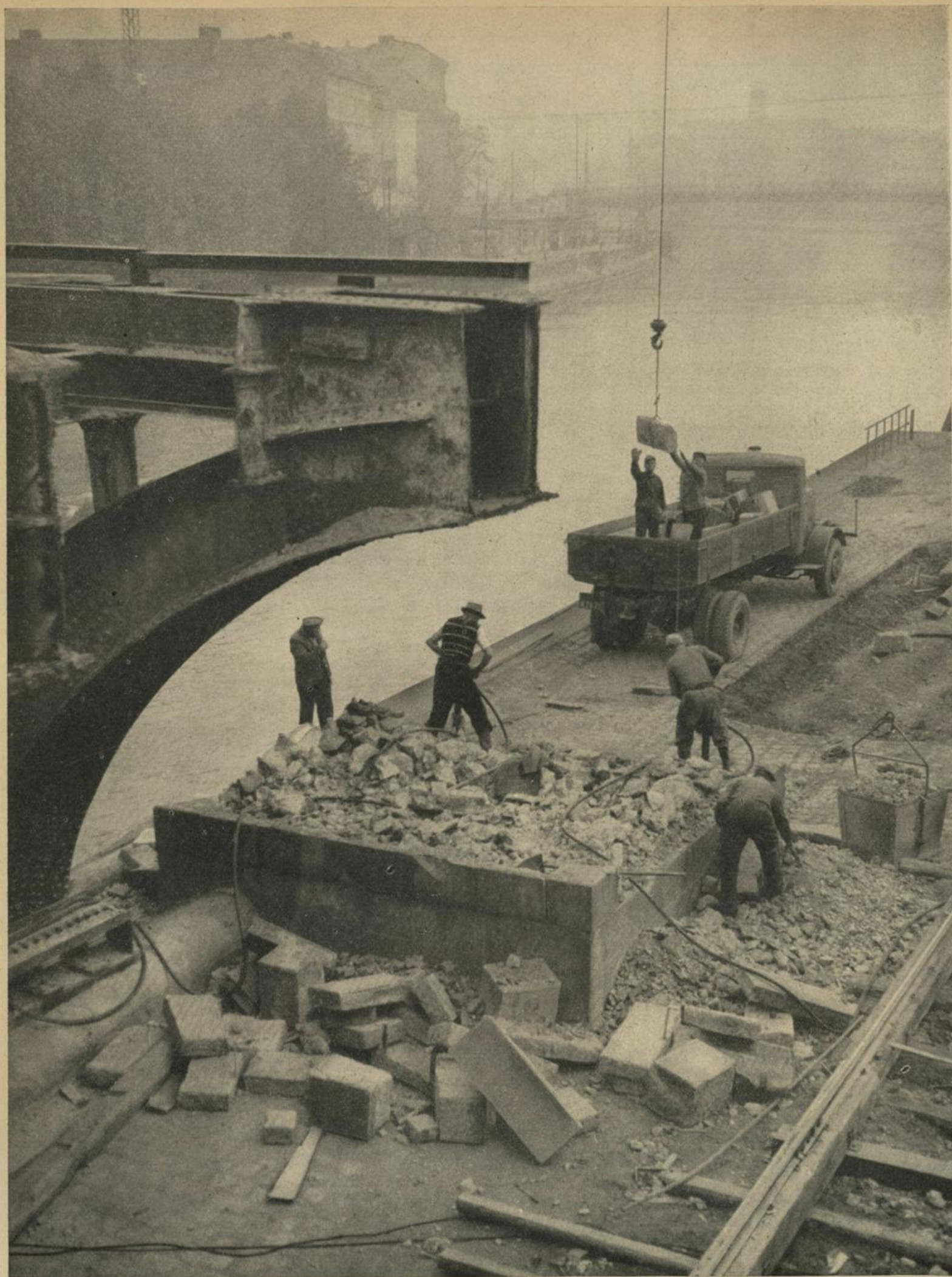
Der „letzte Rest“ der alten Schwedenbrücke
