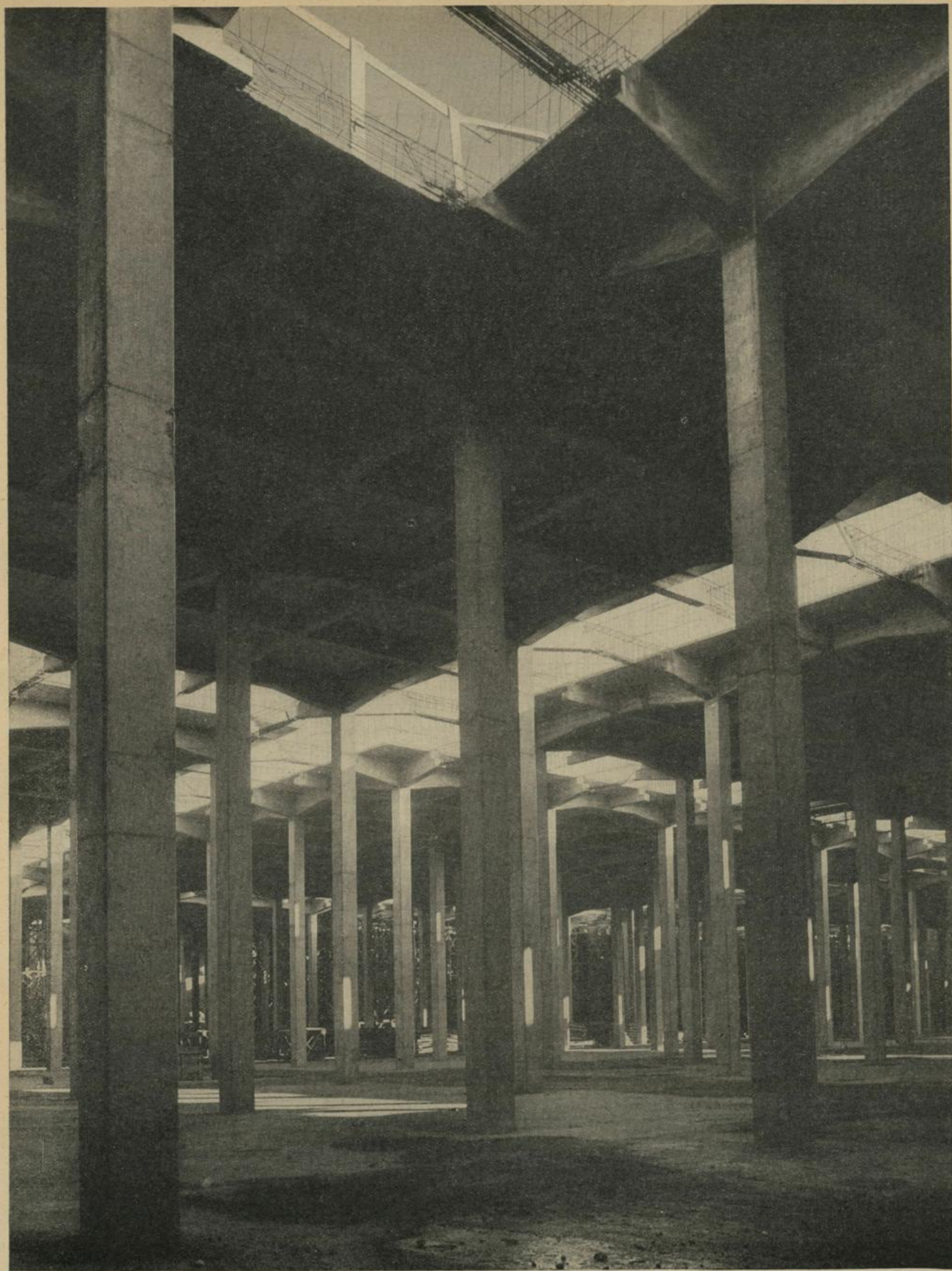
Eine Kammer des Wasserspeichers Neusiedl
