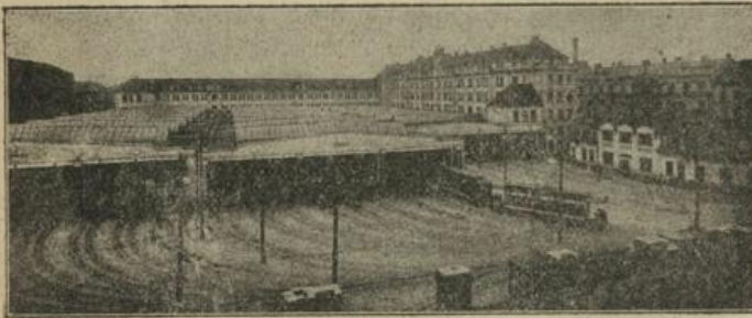
Fig. 3. Gesamtansicht der neuen Bahnhofsanlage Favoriten. Rechts Abfertigungsgebäude (vgl. auch Fig. 4).
