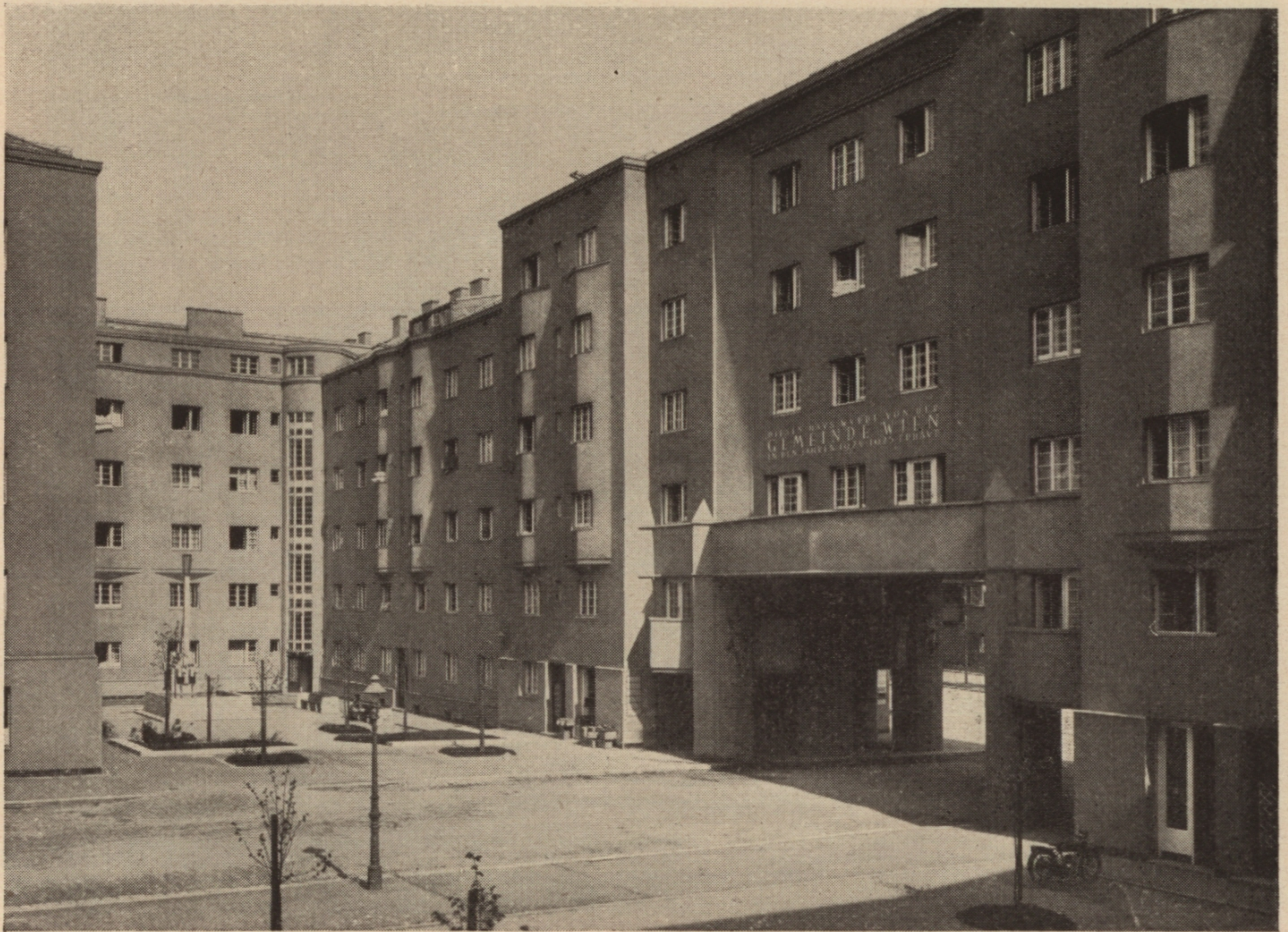
Wohnhausbau Kreuzgasse – Antonigasse, XVIII. Bezirk. Straßenhof. Arch. Erich Leischner.
