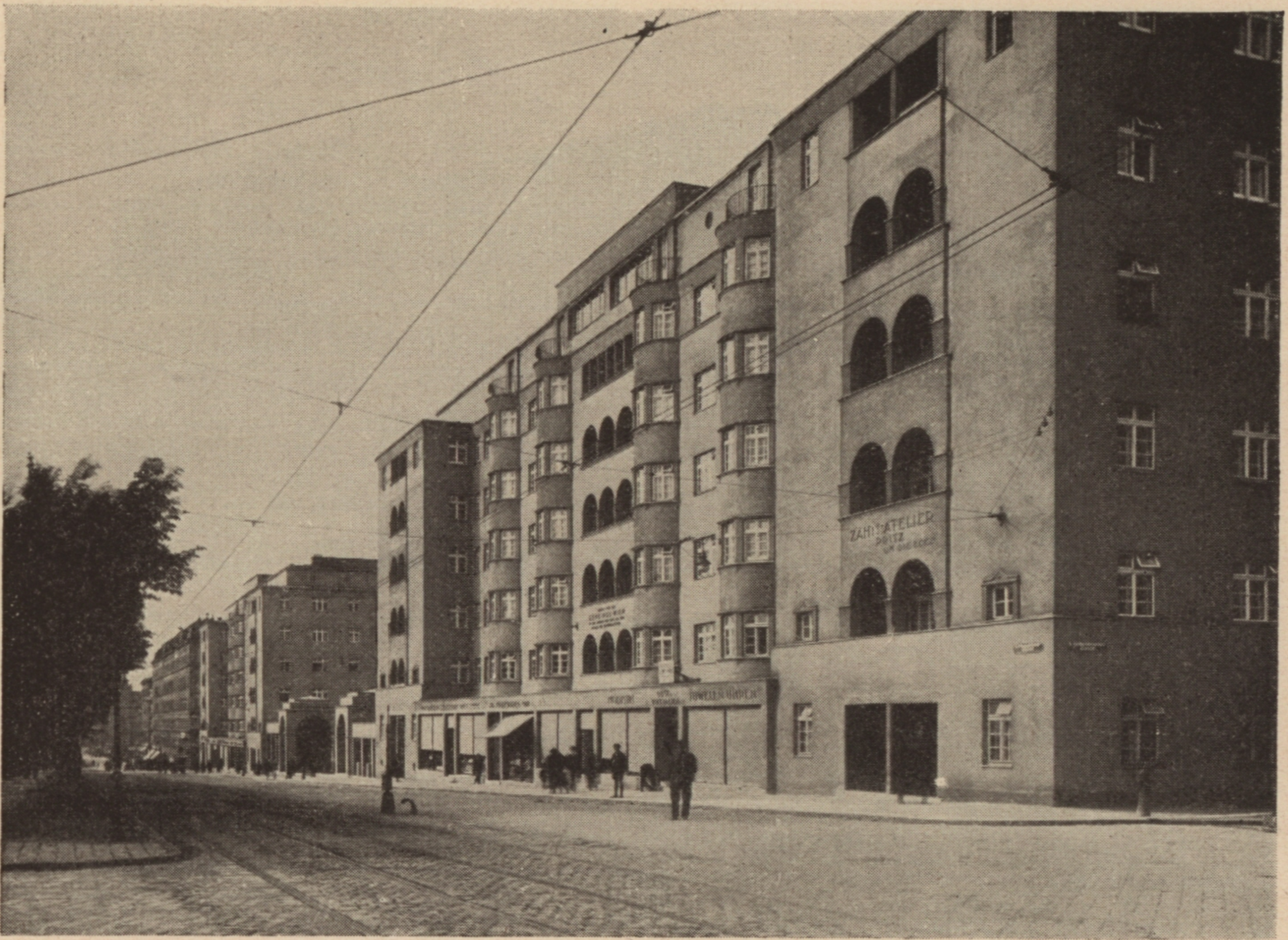
Wohnhausbau „Reumannhof“ V. Bezirk. Front gegen den Margarethengürtel. Arch. H. Gessner.
