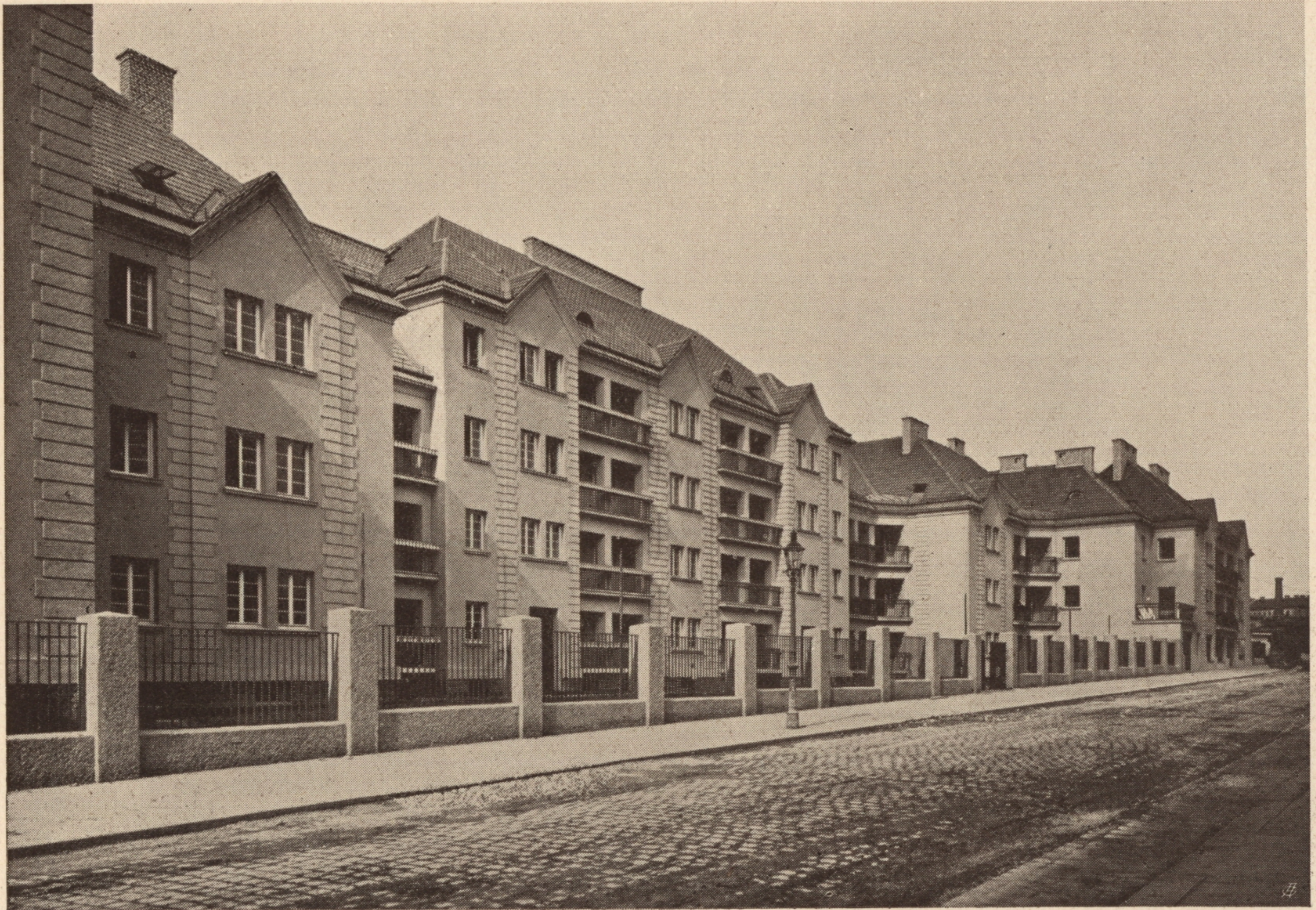
Die Wohnhausanlage XIII., Penzinger Straße—Cumberlandstraße (Ansicht Weinzierlgasse)
