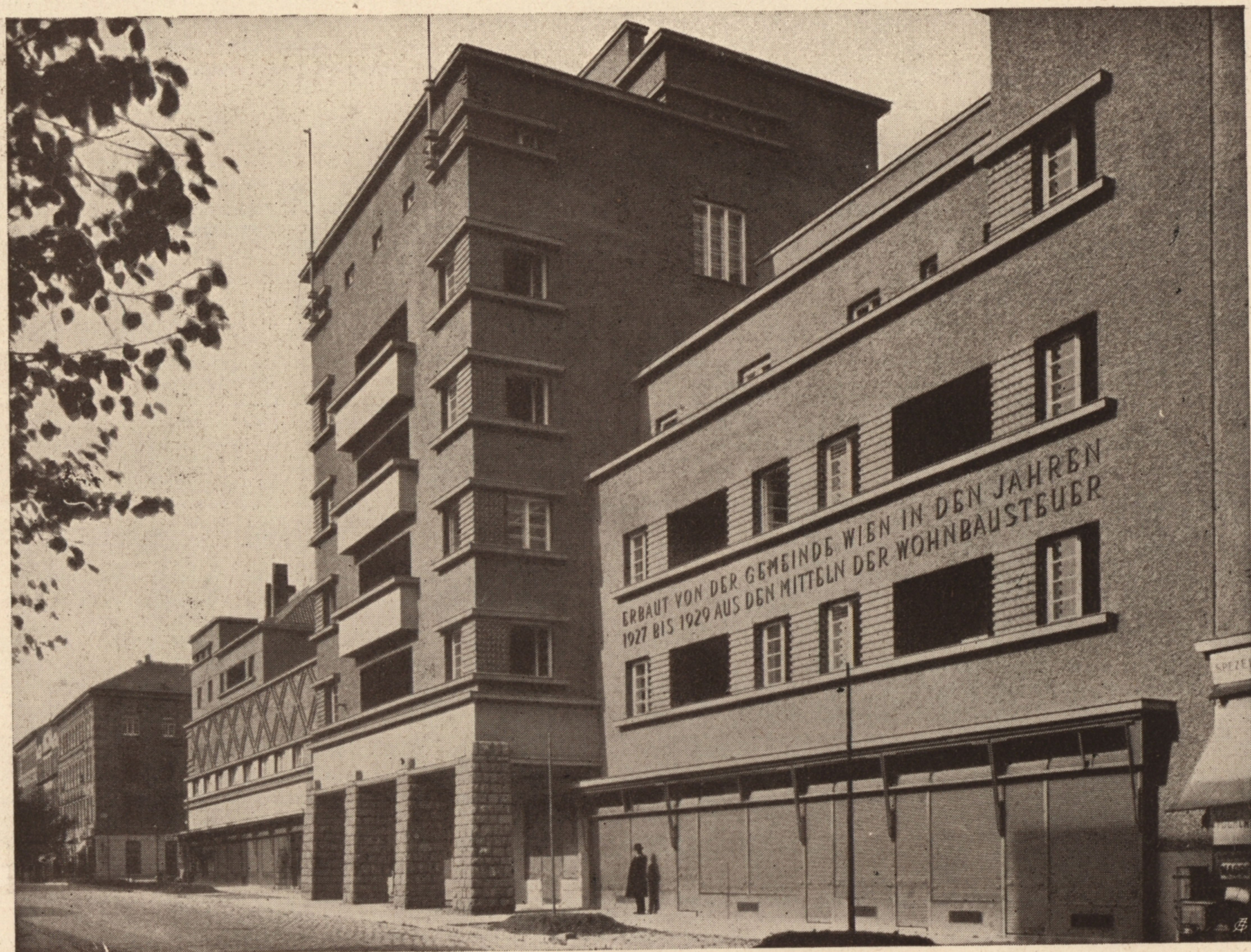
Die Wohnhausanlage XIII., Hütteldorfer Straße—Moßbachergasse (Ansicht Hütteldorfer Straße)
