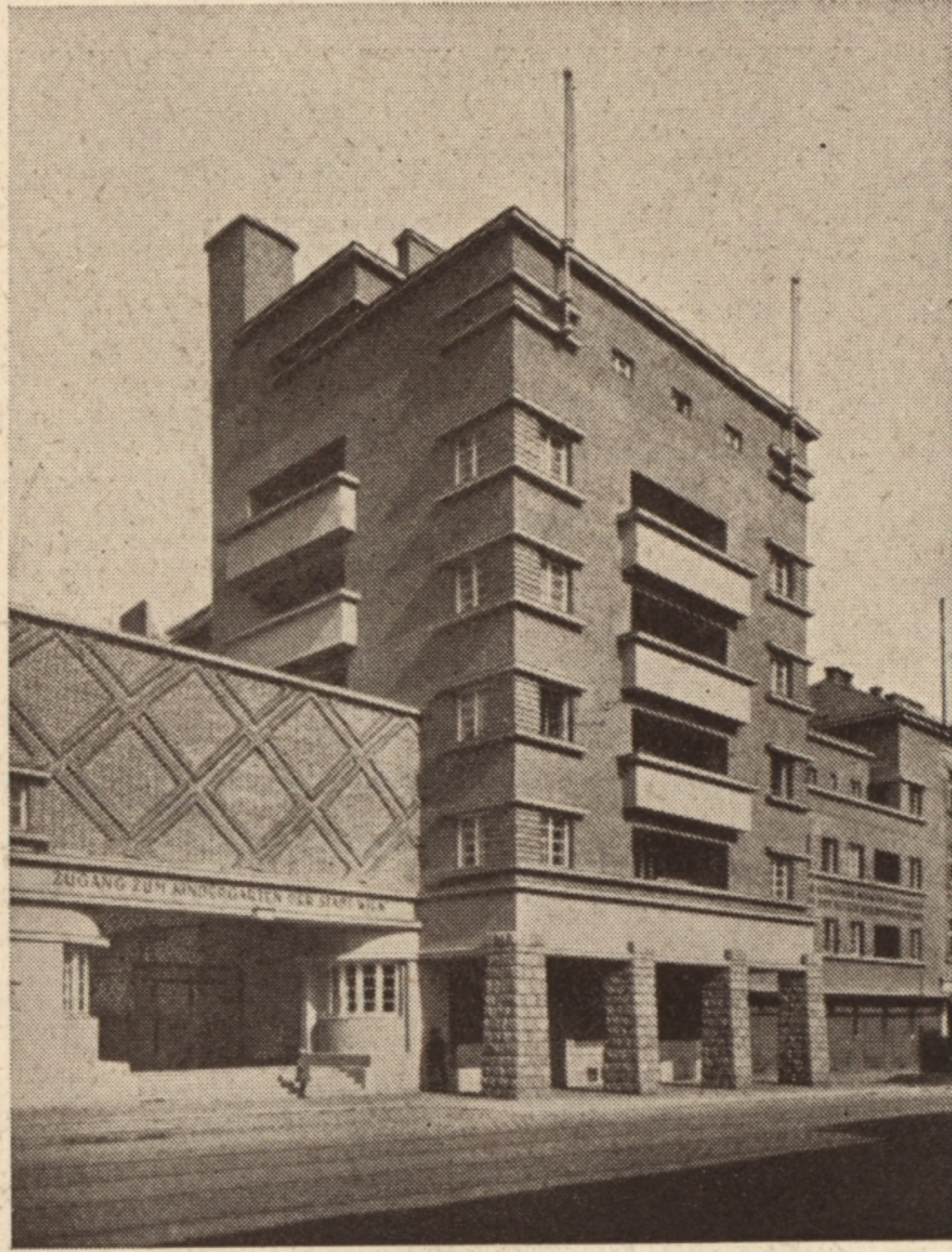
Die Wohnhausanlage XIII., Hütteldorfer Straße—Moßbachergasse (Teilansicht Hütteldorfer Straße)
