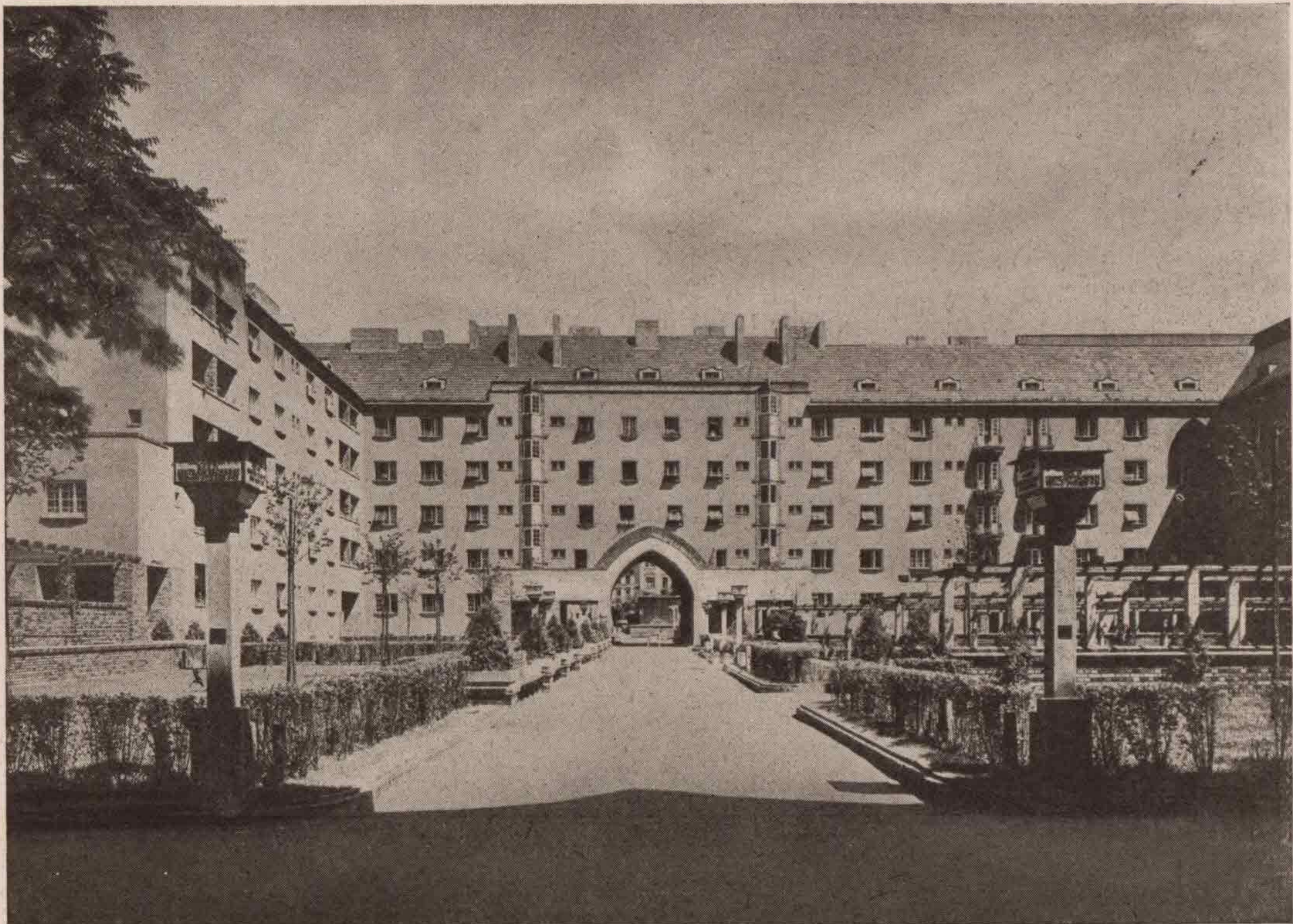
Neue Wohnhausanlage, III. Bez., auf den Gründen der ehemaligen Krimsky-Kaserne (Blick gegen die Gartenseite des Traktes Hainburgerstraße)
