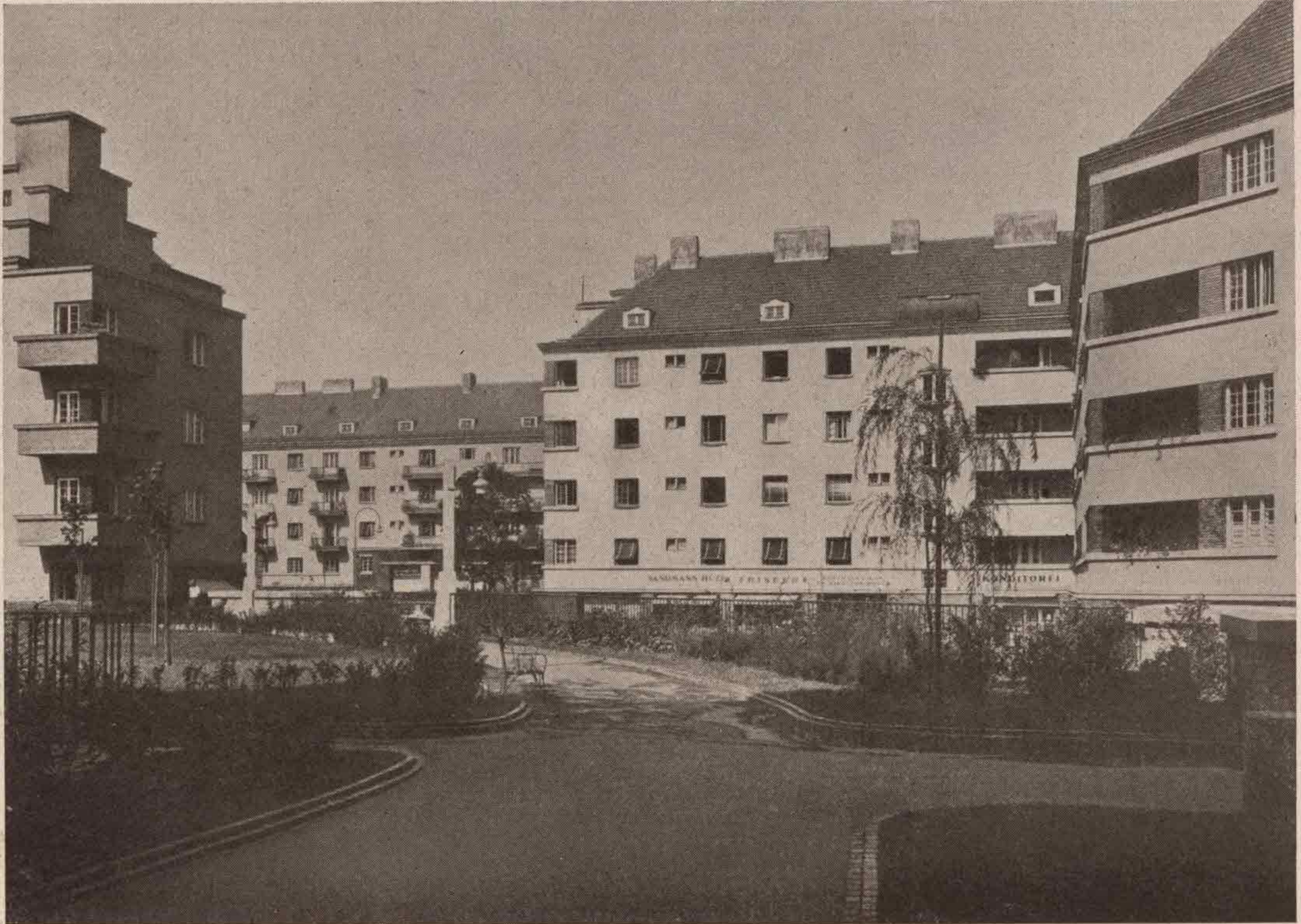
Neue Wohnhausanlage, III. Bez., auf den Gründen der ehemaligen Krimsky-Kaserne (Blick von der Terrasse gegen die Rabengasse)
