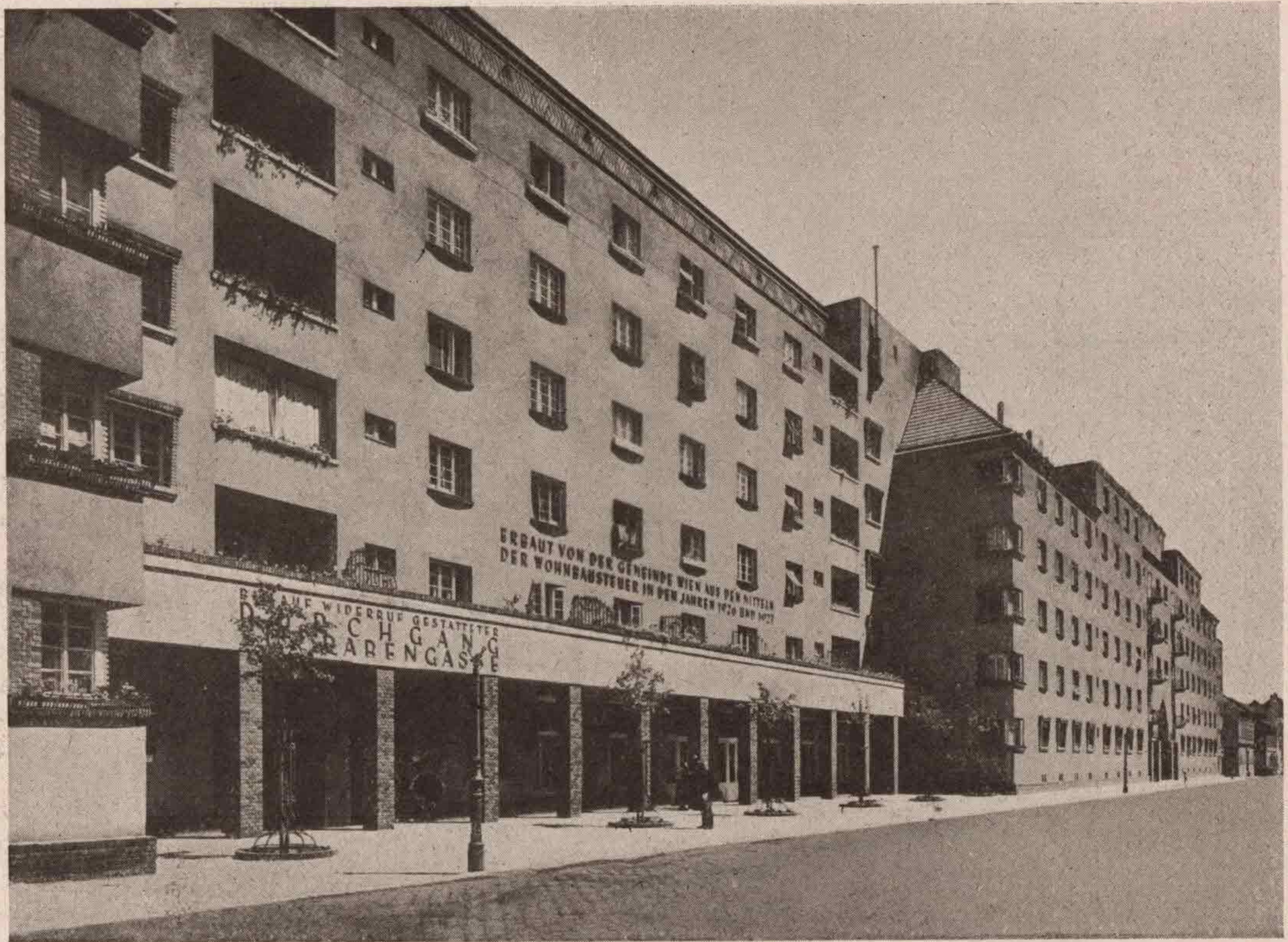
Neue Wohnhausanlage, III. Bez., auf den Gründen der ehemaligen Krimsky-Kaserne (Front Baumgasse)
