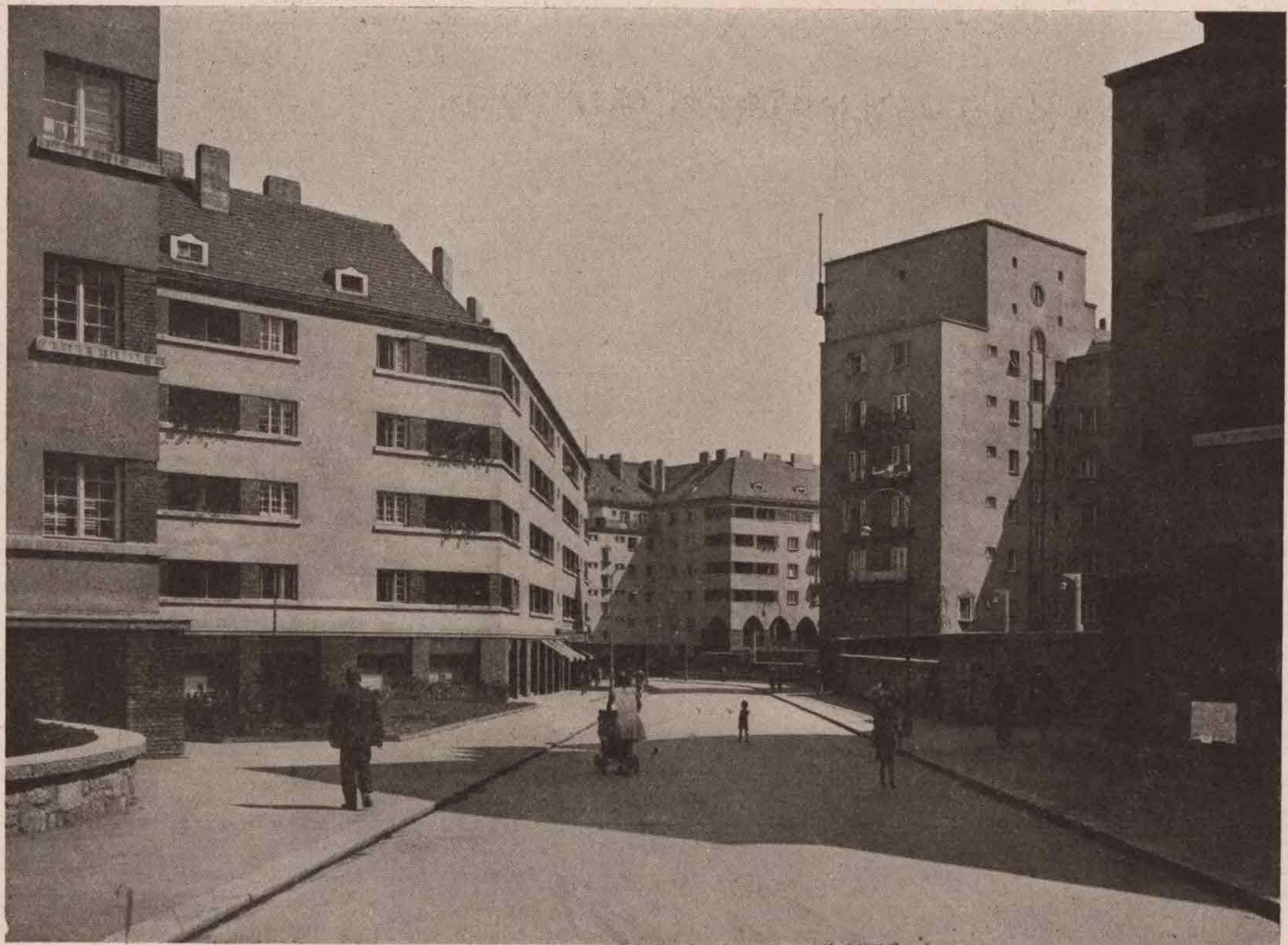
Neue Wohnhausanlage, III. Bez., auf den Gründen der ehemaligen Krimsky-Kaserne (Rabengasse)
