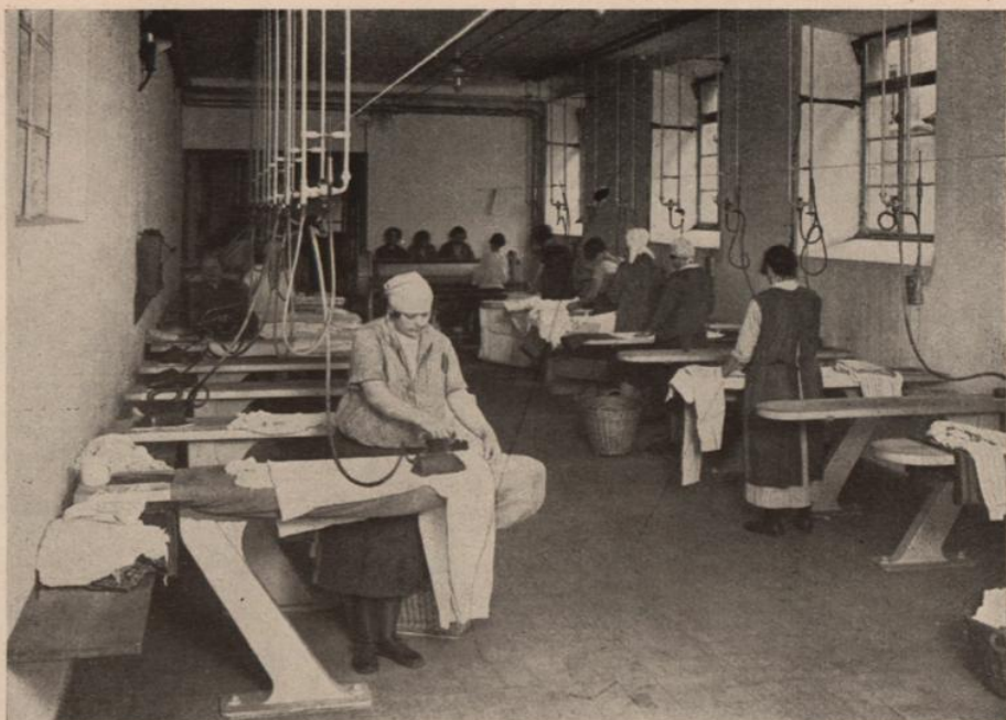
Zentralwaschküche in der städtischen Wohnhausanlage, XII, Wienerbergstraße. Bügelraum.
