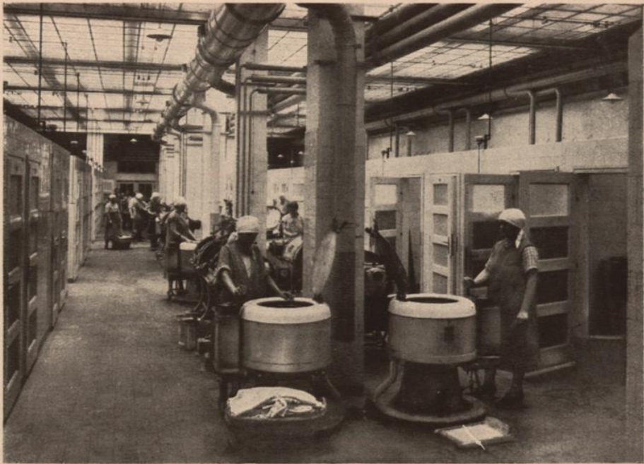
„Der Waschttag von heute.“ Zentralwaschküche in der städtischen Wohnhausanlage, XII, Wienerbergstraße. Waschsaal.
