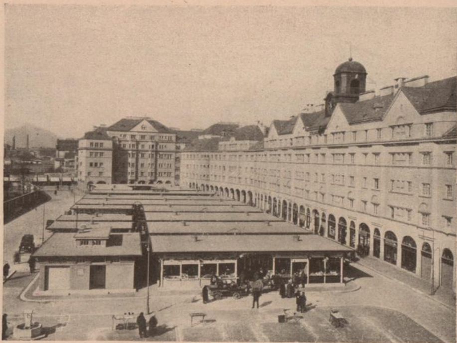
Städtische Wohnhausanlage mit Markt, XXI, Pitkagasse, „Schlingerhof“.
