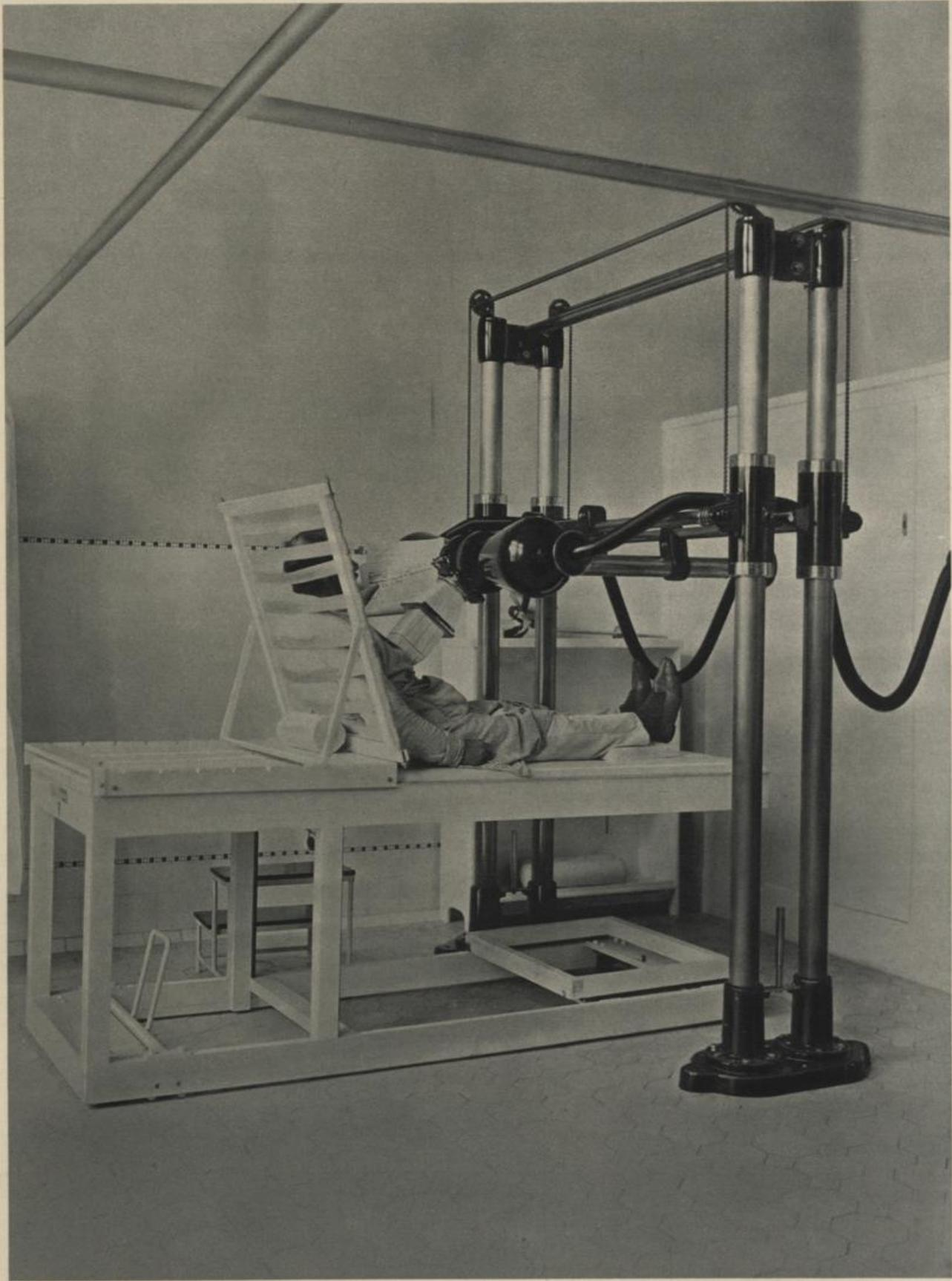
RÖNTGEN APPARAT ZUR TIEFENBESTRAHLUNG
