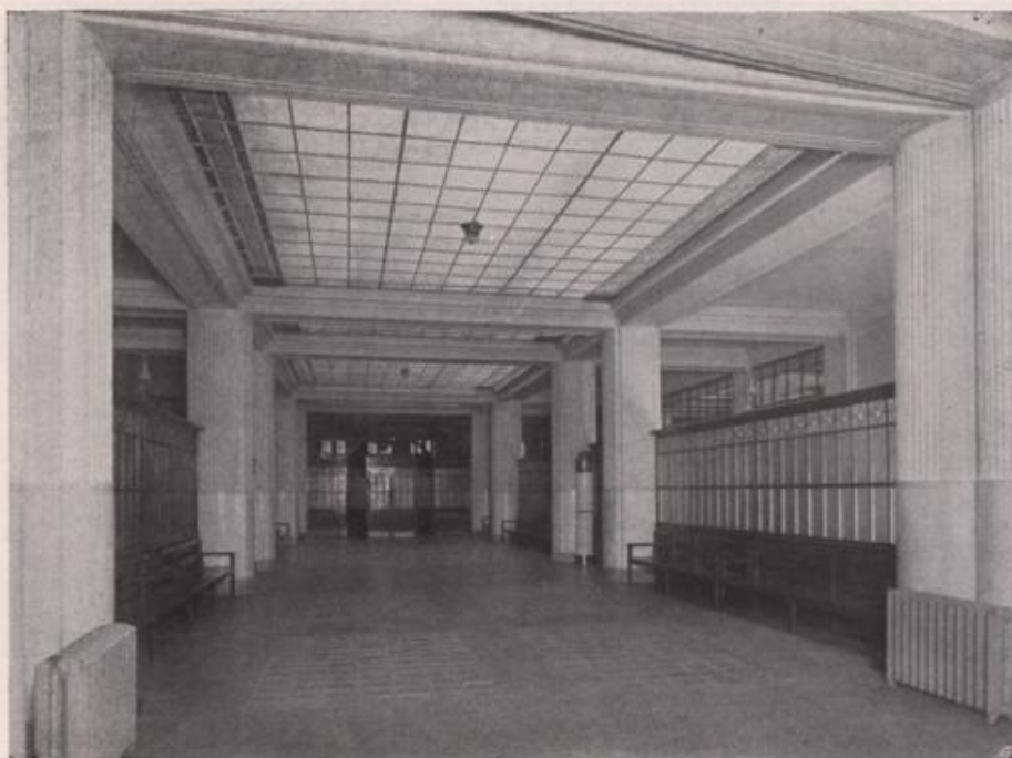
Warteraum des Ambulatoriums
