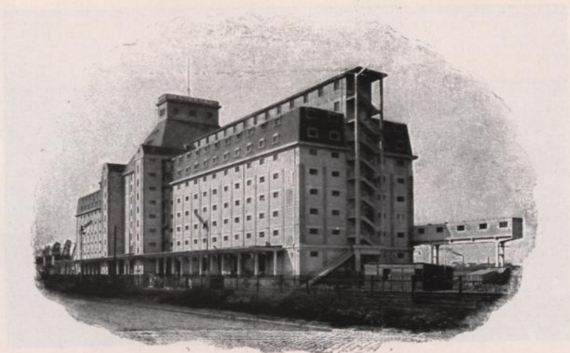
Das Lagerhaus der Stadt Wien erbaut von der Firma Maschinenfabriks-Aktiengesellschaft N. Heid als Generalunternehmer
