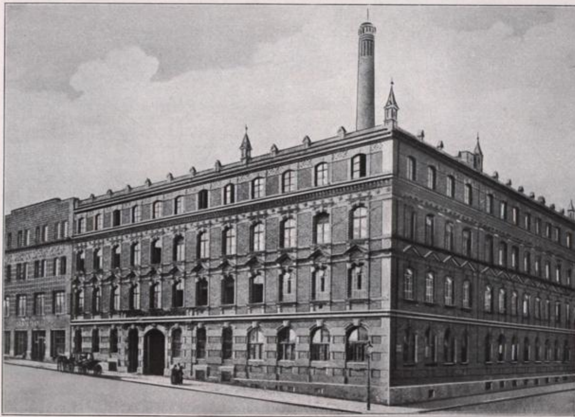
Zentralgebäude der Konsumgenossenschaft Wien und Umgebung
