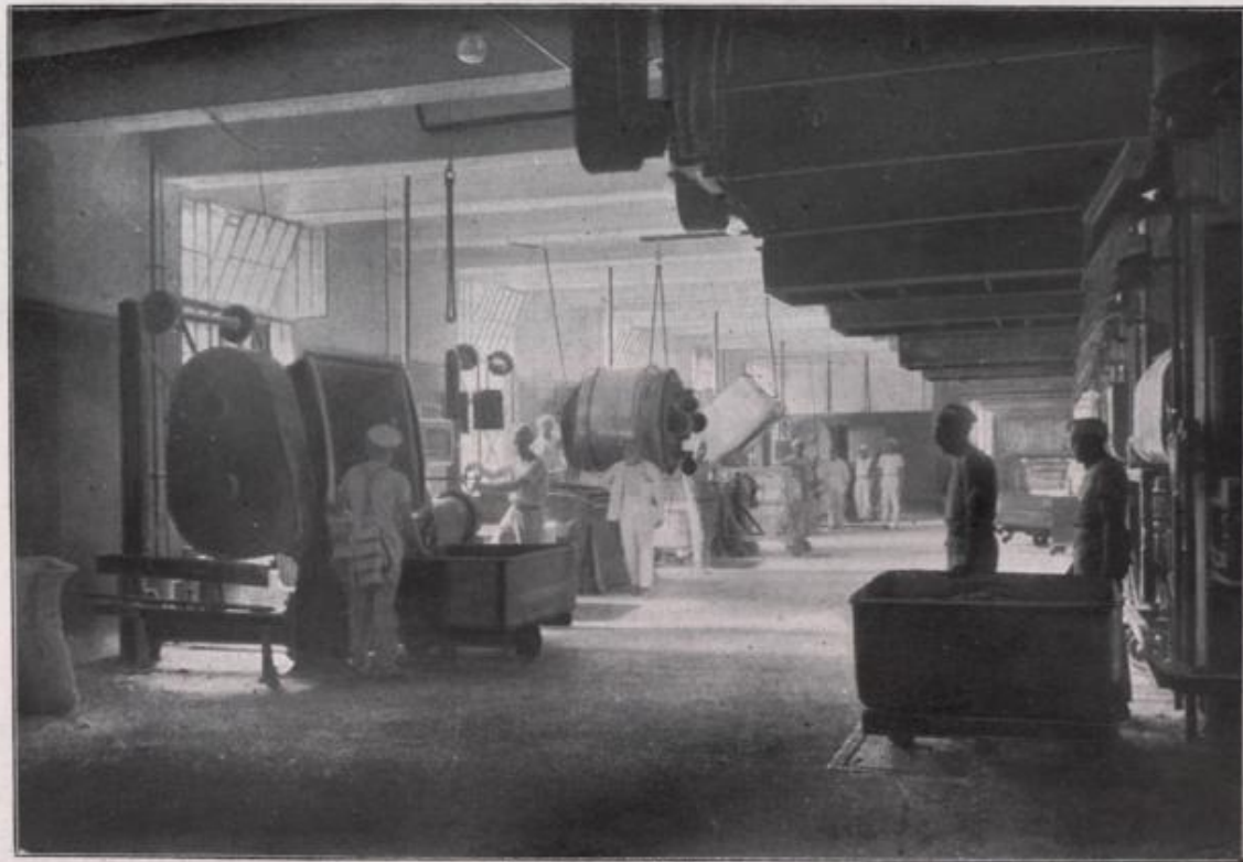
Knetraum mit Siebanlage
