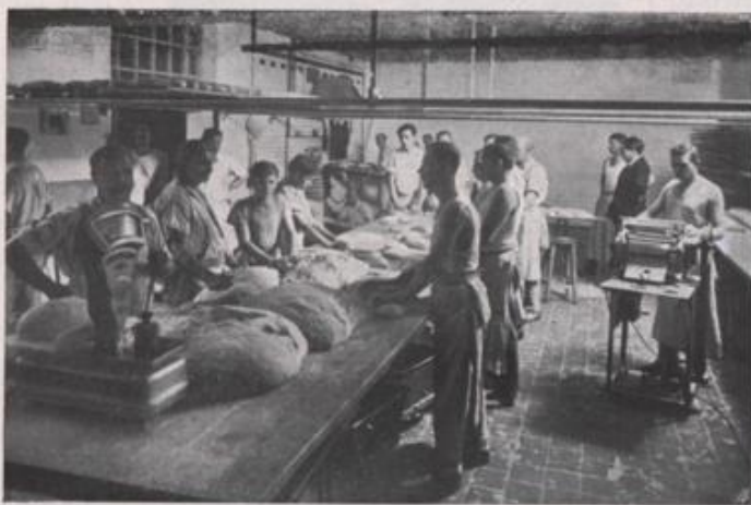
Arbeitsraum und Dampfbacköfen II
