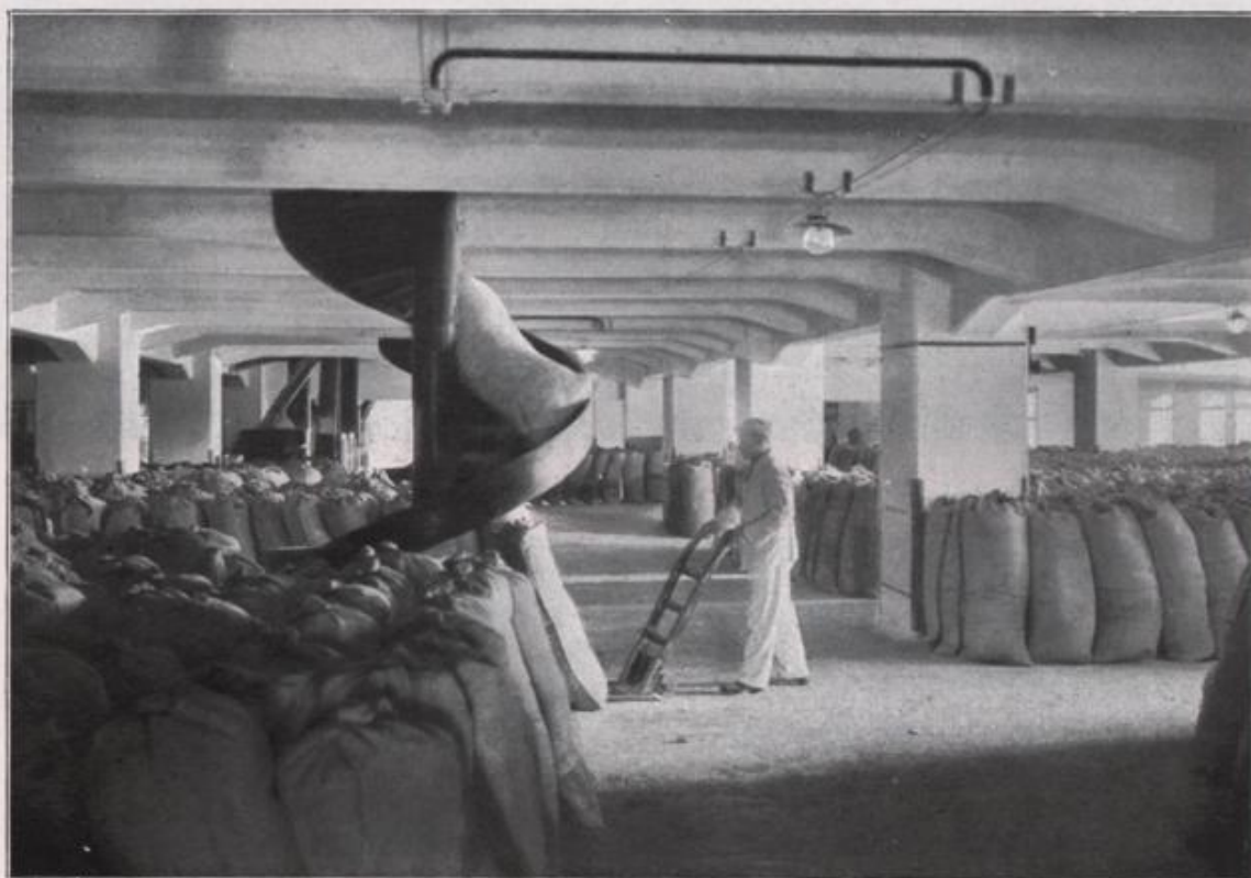
Abwärtsbeförderung von Mehl
