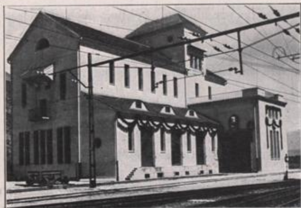
Elektrifizierung der Arlbergbahn: Unterwerk Zirl in Tirol
