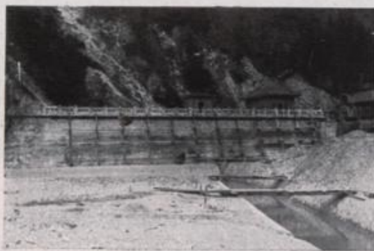
Talsperre des Werkes Erlaubboden
