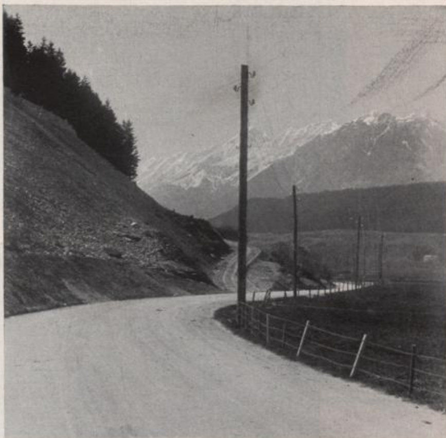
Spramex-Oberflächenbehandlung, Wattens-Bundesstraße, 17 km östlich von Innsbruck, ausgeführt August 1926, photographiert Juni 1927. Eigenregiearbeit des Bundesstraßendienstes Innsbruck-Ost, Baurat Ing. Otto Wessely
