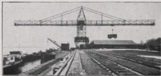
Kranbahn der Schifffahrts A. G. Bayerischer Lloyd, Wien II
