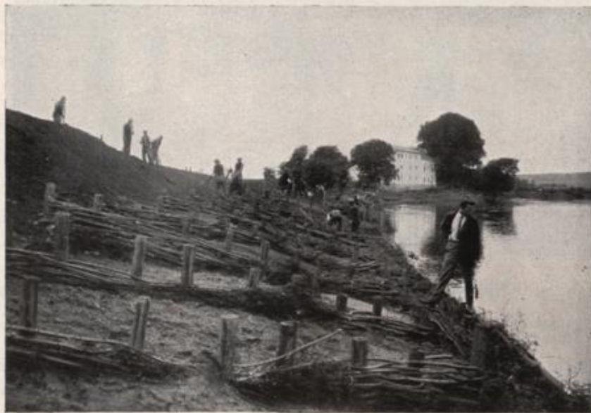
Uferbruchverbauung an der March bei Jedenspeigen
