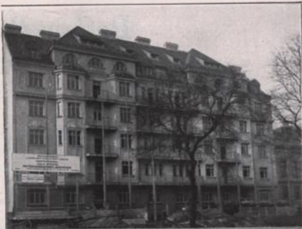
Beamten-Wohnhausbau, Wien, II., Schüttelstraße 21, der Österreichischen Credit-Anstalt für Handel und Gewerbe
