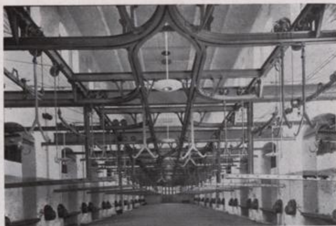
Schlachthalleneinrichtung St. Marx
