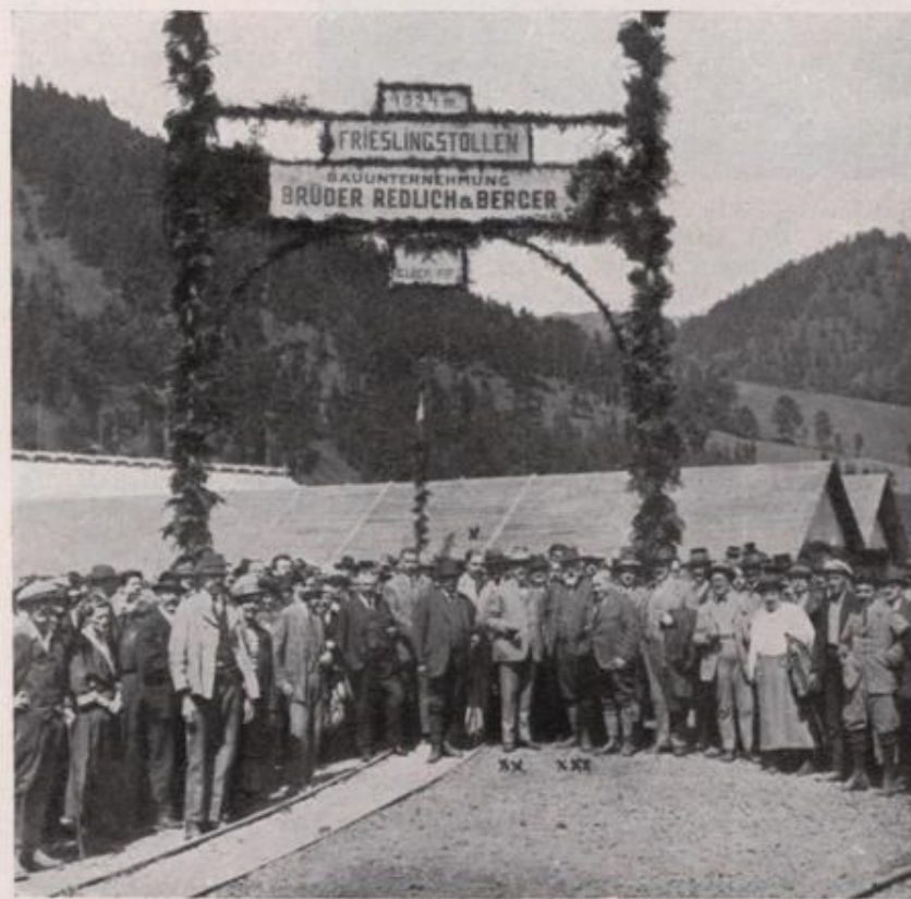
Frieslingstollen-Durchschlag am 20. Juli 1924 ××× Bundespräsident Hainisch, ×× Bürgermeister Seitz
