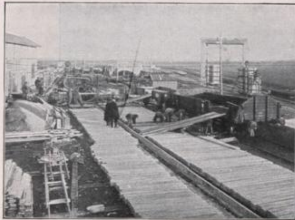
Eisenbetonbalken-Erzeugung für das Arar
