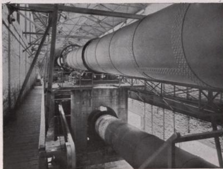
Werk Mannersdorf, Seitenansicht des 50-Meter-Drehofens
