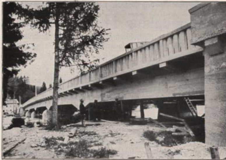
Eisenbetonbrücke, 113 Meter lang, über den Lech bei Reutte in Tirol, erbaut 1926.
