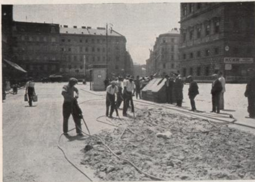
Aufbruch der alten Straßendecke in der Nordbergstraße mit Preßluftwerkzeugen
