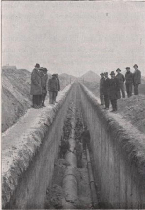
Doppel-Wasserleitungs-Rohrstrang 600 und 150 mm l. W. Wien-Breitensee.
