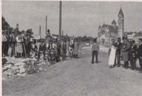
Hervicusgasse, II. Teilstrecke vom Marshallplatz bis zum Südwestfriedhof. Neuanlage der Straße durch ein Haferfeld. „Legen und Bewalzen des Grundbaues“.
