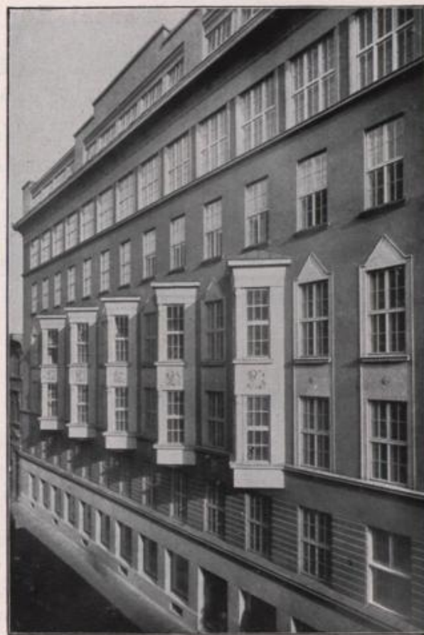
Kanzlei-, Werkstätten- und Magazinsgebäude, IX., Höfergasse 8-10
