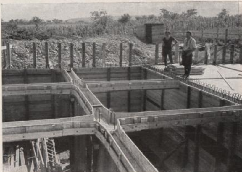
Wasserbehälter für die obere Druckzone in Brunn am Gebirge im Bau. Schalung der Wände und Decke vor der Vollendung
