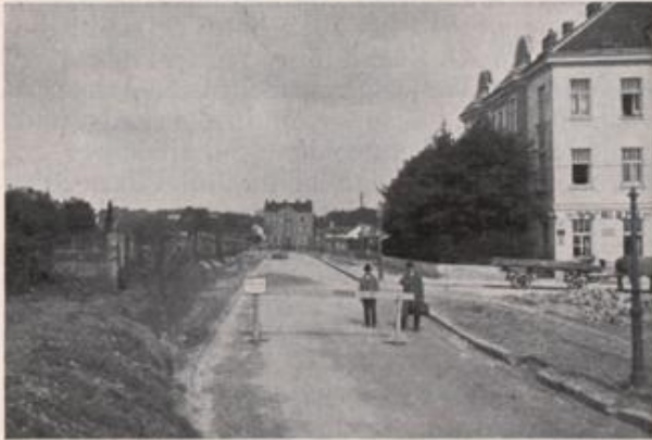
Hervicusgasse, I. Teilstrecke von Hetzendorferstraße bis Marshallplatz. „Fahrbahn ist bis auf die Oberflächenteerung fertig“.
