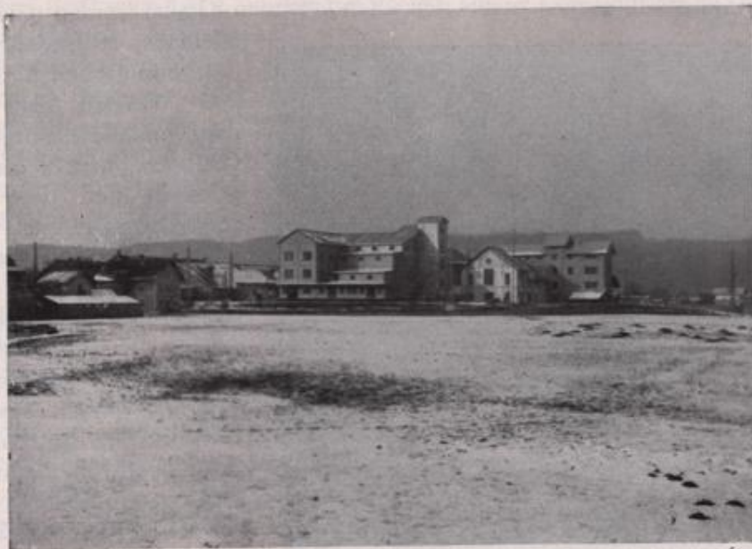
Saullich-Werk Kirchbühl Neue Zementmühle und Zementspeicheranlage während des Baues
