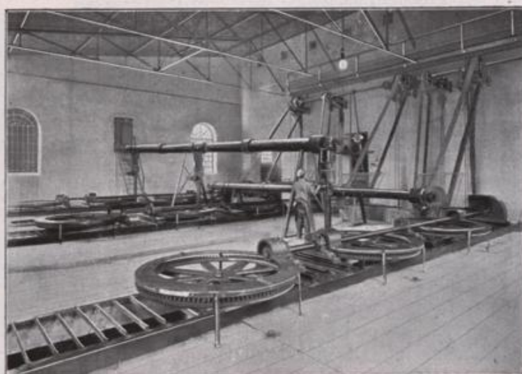
Werk Mannersdorf, Dickschlammbehälter vor den Öfen
