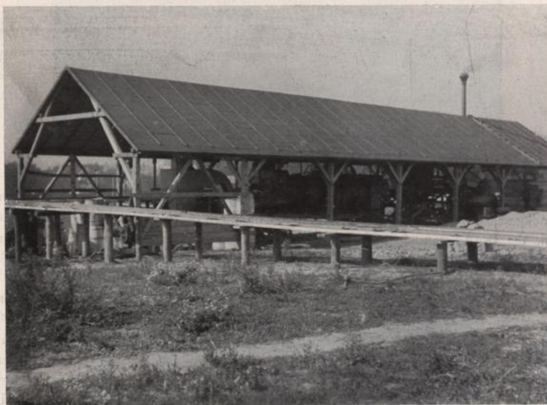
Mischanlage für Teer- und Bitumenmakadamisierungen
