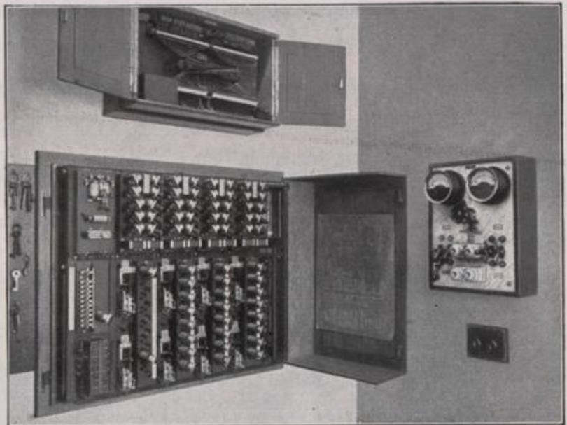
Vollautomatische Telephonzentrale „Hekaphon 37“ mit Rangierobjekt und Ladeschalttafel
