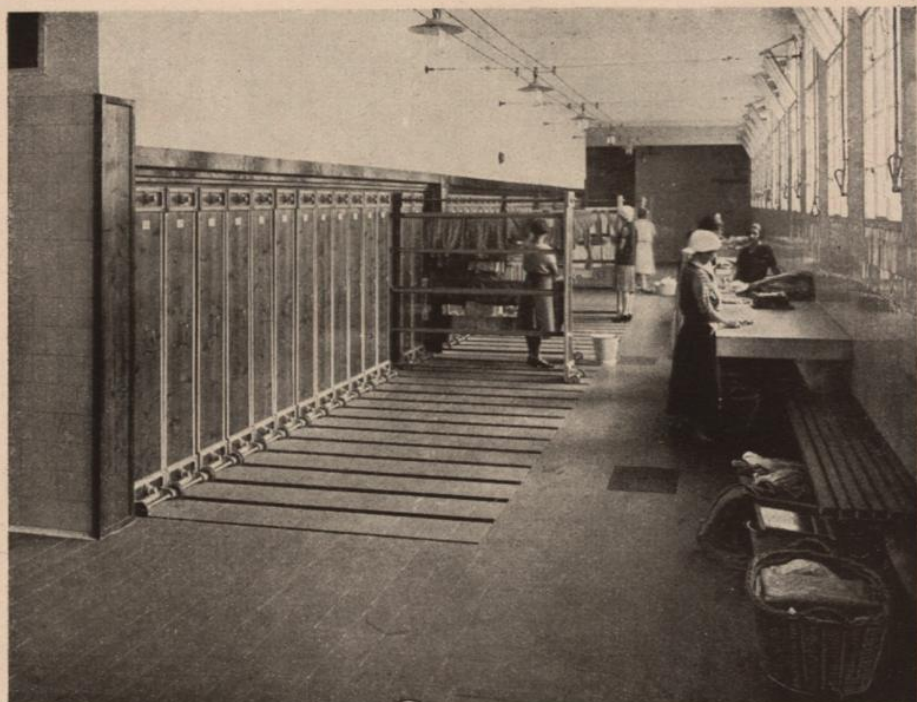
Zentralwaschküche in der städtischen Wohnhausanlage, XXI, Jedleseerstraße. Trockenraum mit Trockenkulissen.
