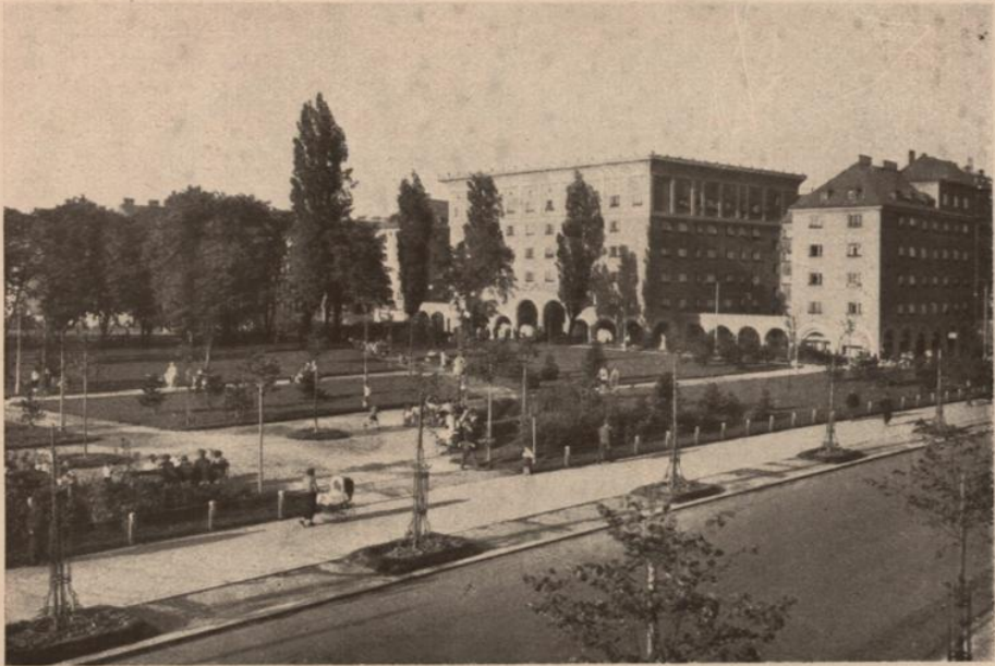
Städtischer Wohnhausbau, XV, Vogelweidplatz. Im Vordergrund der mit Verwertung der Baumbestände des aufgelassenen Schmelzer Friedhofes geschaffene öffentliche Garten.
